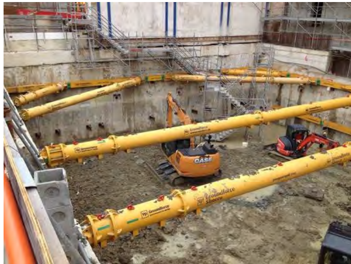
Figura 10.4 – Esempio puntoni metallici
