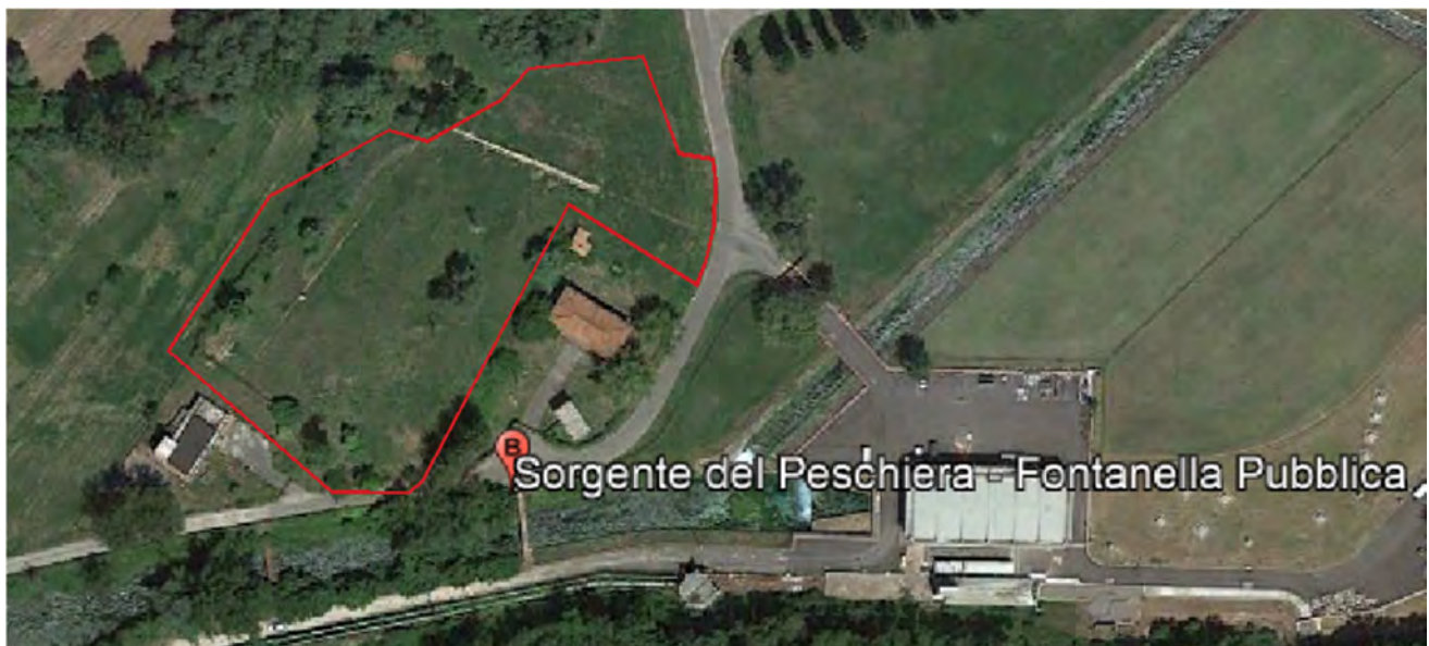
Figura 7.1 – Aree di cantiere M1 (Piana di San Vittorino)
