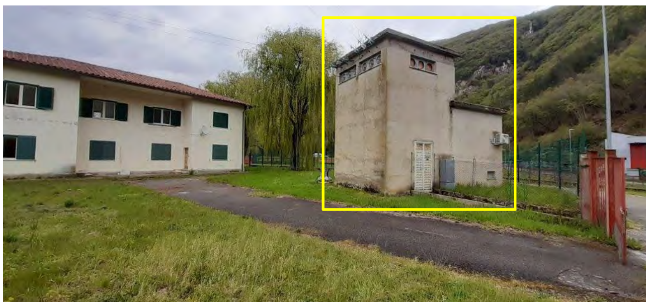
Figura 6.1 – Aree di cantiere Manufatto M1 – Cabina Elettrica
