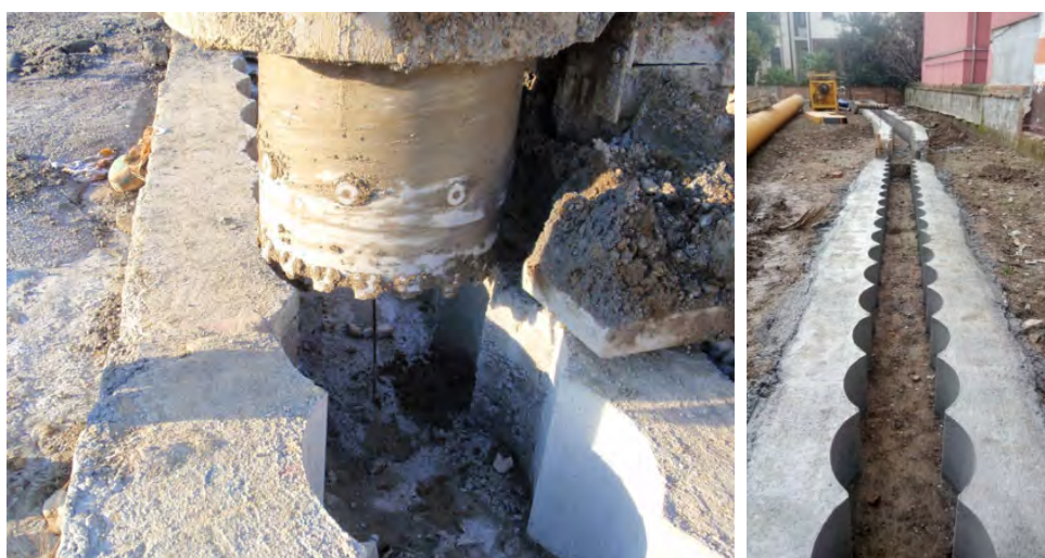
Figura 10.2- Esempio di correa con sagoma delle perforazioni
