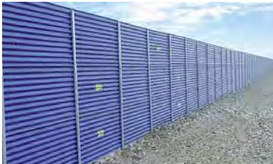
Figura 7.2 – Recinzione di cantiere
