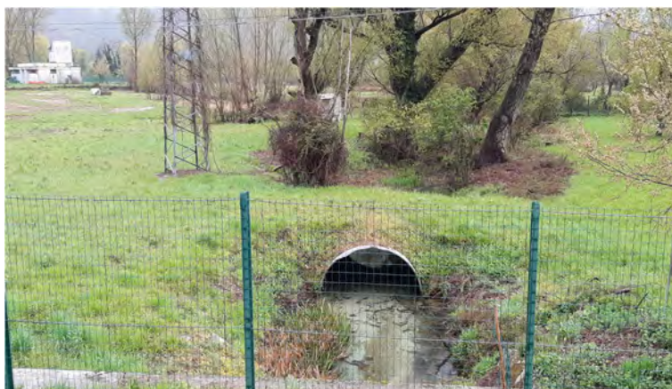
Figura 6.5 – Fosso presente limitrofo l'area di cantiere
