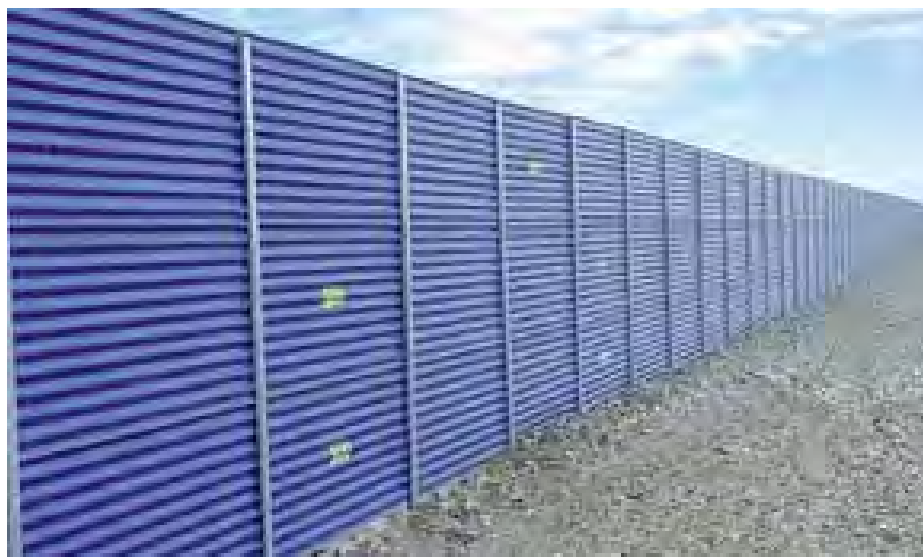
Figura 7.2 – Recinzione di cantiere
