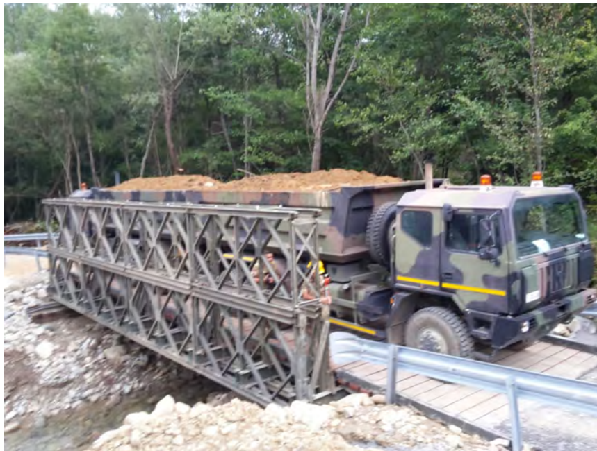
Figura 7.7 – Esempio Ponte Bailey
