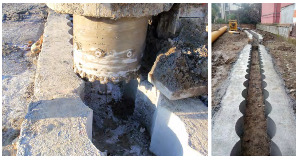
Figura 10.4- Esempio di correa con sagoma delle perforazioni
