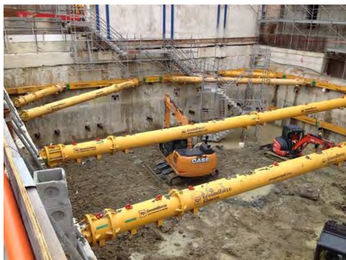
Figura 10.6 – Esempio puntoni metallici
