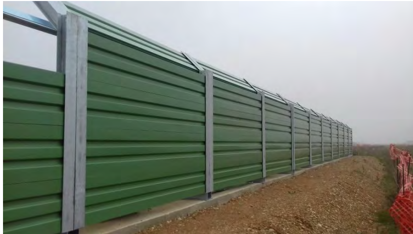
Figura 7.3 – Esempio Barriera antirumore
