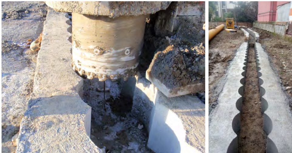
Figura 10.2- Esempio di correa con sagoma delle perforazioni
