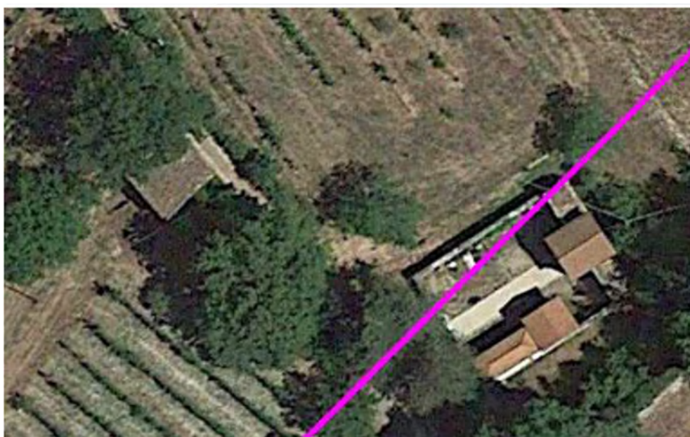
Interferenze 5A (destra) e 5B (sinistra) rispetto al tracciato di progetto (tratto M3-M4)
