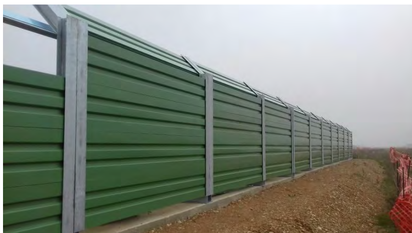
Figura 7.3 – Esempio Barriera antirumore
