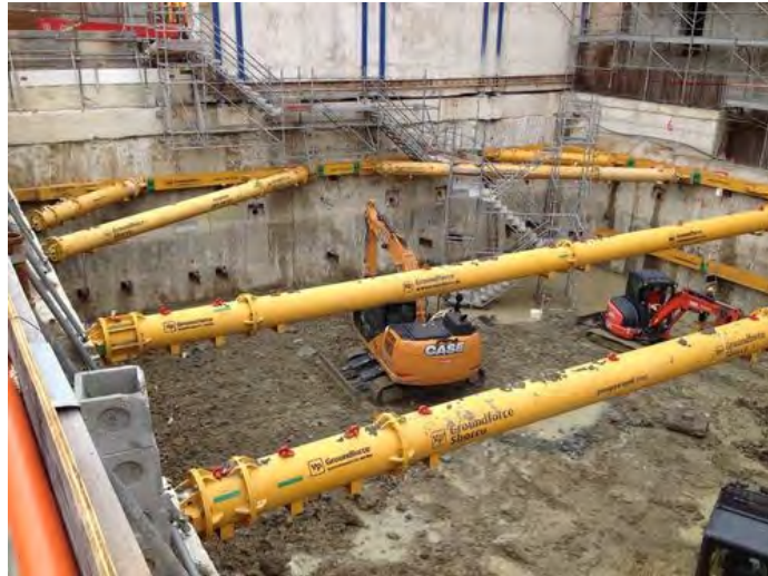
Figura 10.4 – Esempio puntoni metallici
