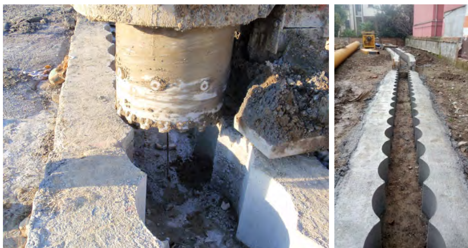
Figura 10.2- Esempio di correa con sagoma delle perforazioni
