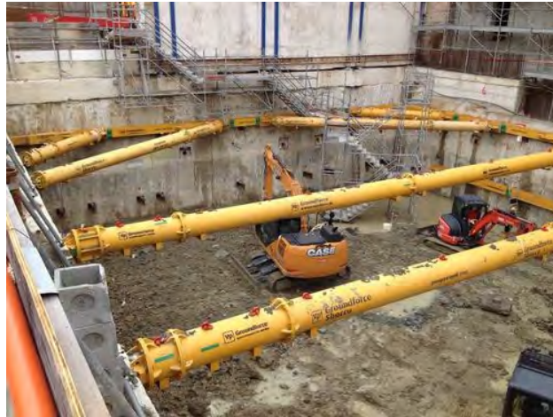
Figura 10.4 – Esempio puntoni metallici
