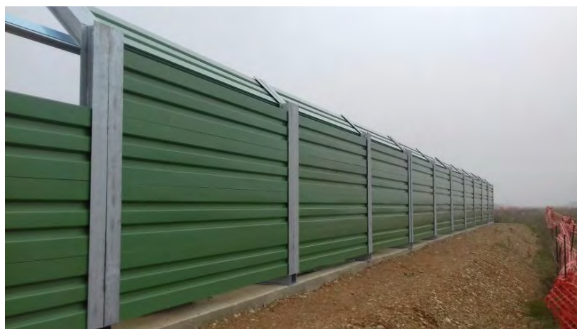
Figura 7.3 – Esempio Barriera antirumore
