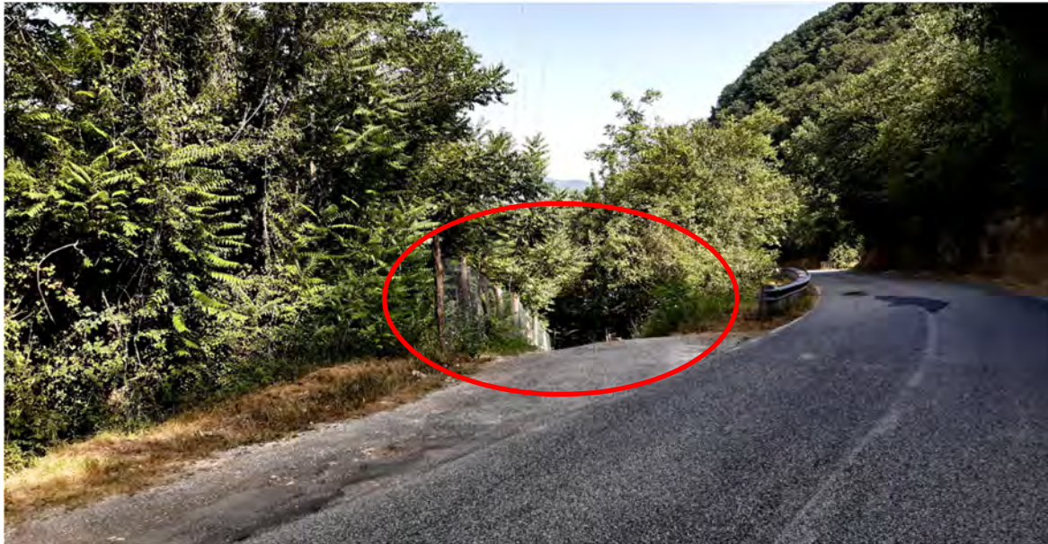
Figura 6.12 – Punto in cui è previsto l'accesso all'area di cantiere
