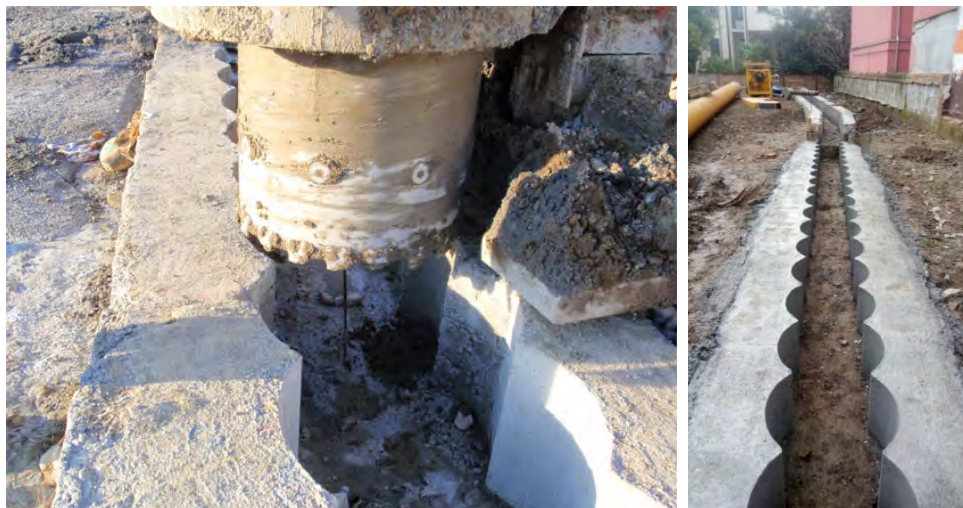
Figura 10.4- Esempio di correa con sagoma delle perforazioni
