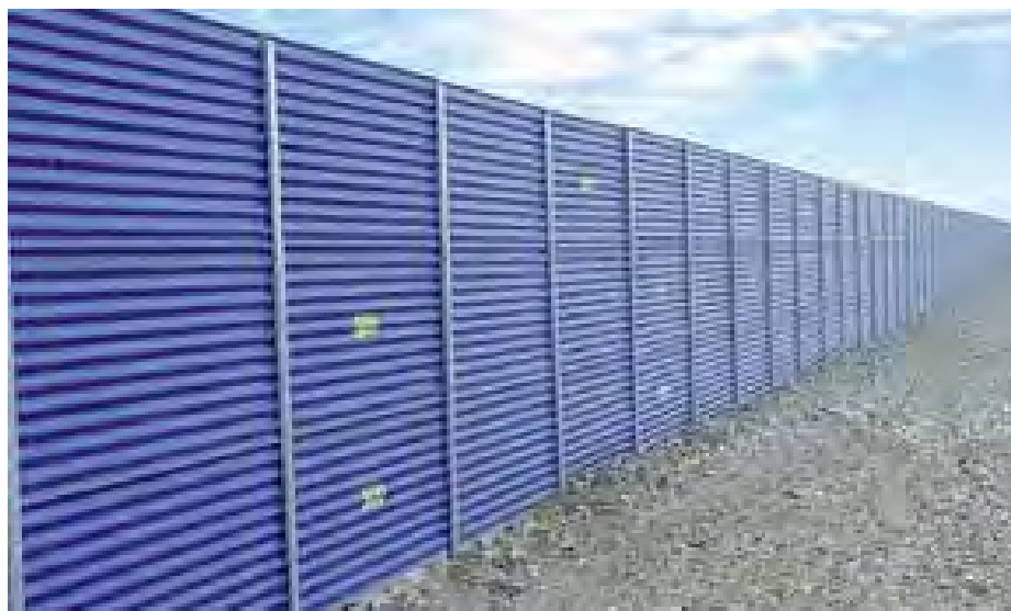
Figura 7.2 – Recinzione di cantiere
