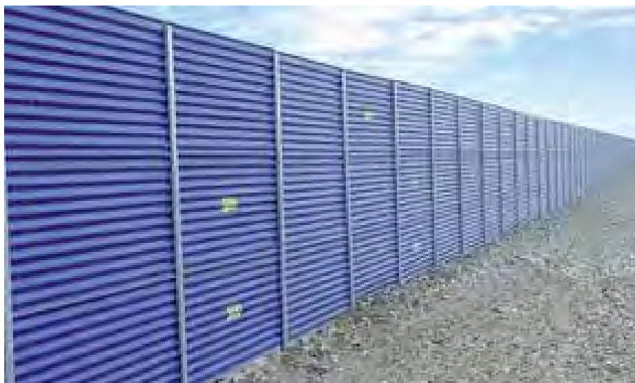
Figura 7.2 – Recinzione di cantiere
