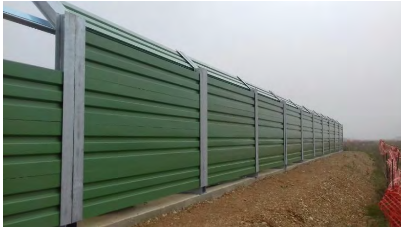
Figura 7.3 – Esempio Barriera antirumore
