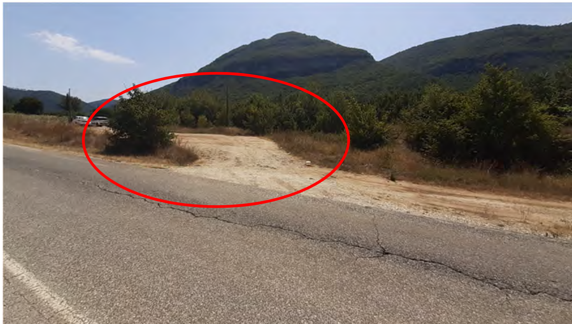
Figura 6.11 – Punto di accesso area di cantiere Turano 2 e pista di collegamento Turano Monte e Turano Valle Monte
