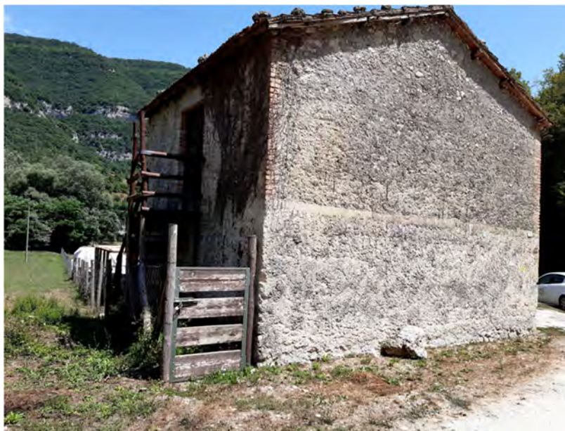
Figura 6.7 – Aree di cantiere Salto Valle – Manifatti da demolire
