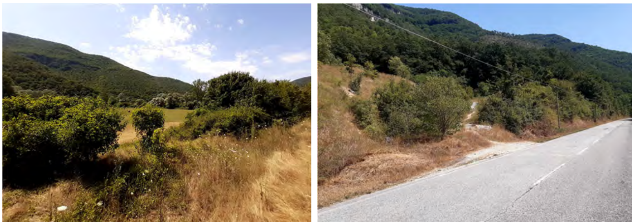
Area di cantiere Turano Monte
