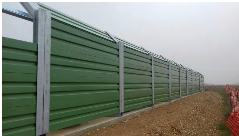
Figura 7.4 – Esempio Barriera antirumore
