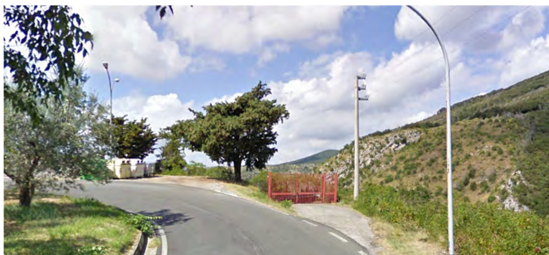
Figura 7.6 – Accesso alla viabilità per raggiungere l'area di cantiere della Vasca di carico
