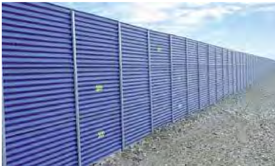
Figura 7.3 – Recinzione di cantiere
