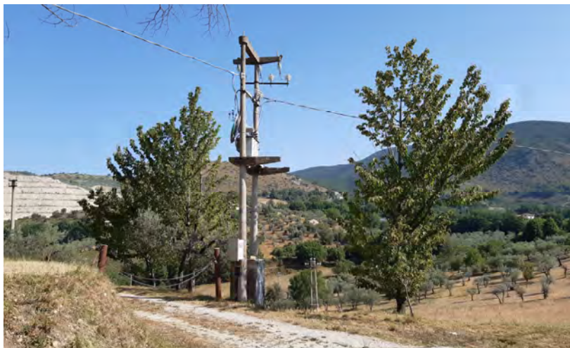
Figura 6.1 – Aree di cantiere Pozzo2 – Cabina Elettrica
