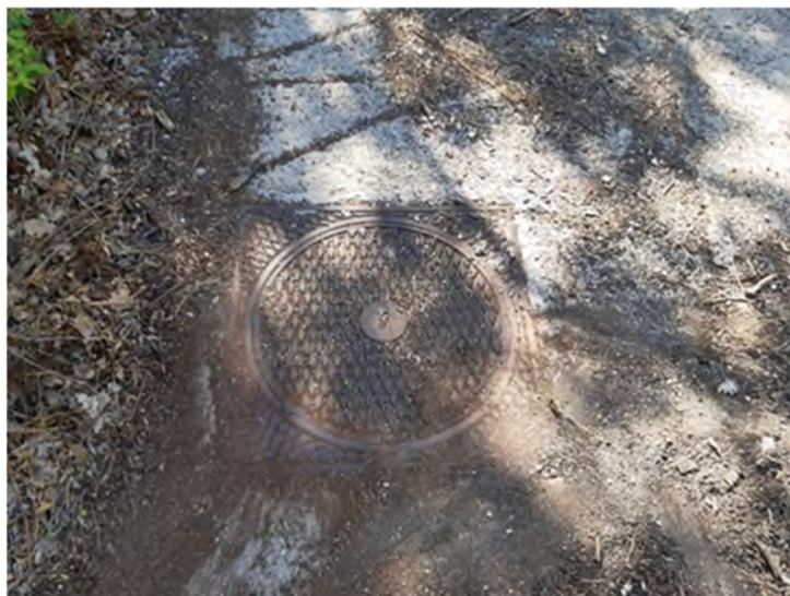
Figura 6.2 – Aree di cantiere Pozzo2 –Rete fognaria esistente sotto viabilità di accesso ad area di cantiere ed all’interno dell’area di cantiere
