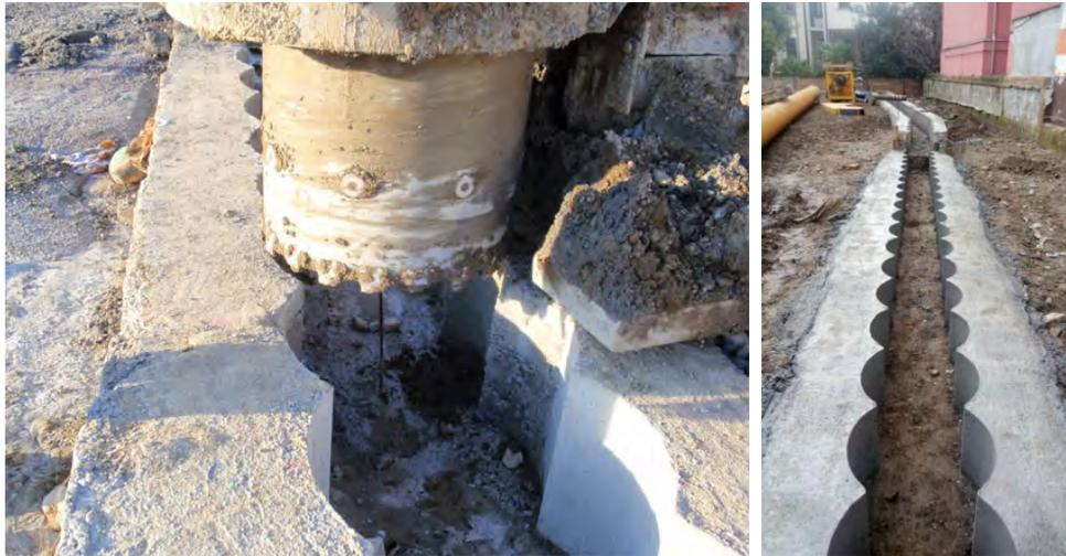
Figura 10.2- Esempio di correa con sagoma delle perforazioni
