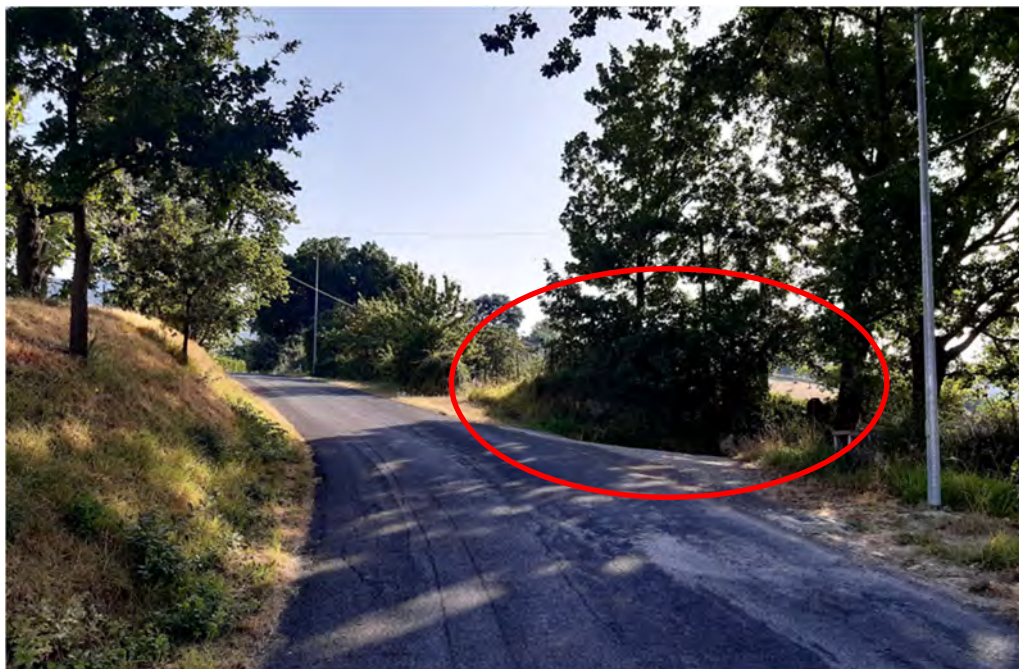
Figura 7.5 – Punto di accesso alla strada di accesso alle aree di cantiere Attacco al Peschiera Destro
