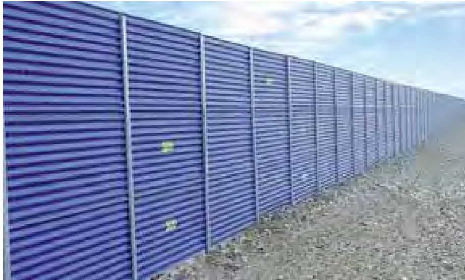
Figura 7.2 – Recinzione di cantiere
