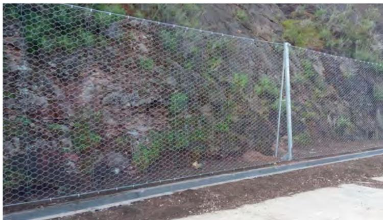
*Figura 6.7 – Esempio reti di protezione contro caduta massi.*
