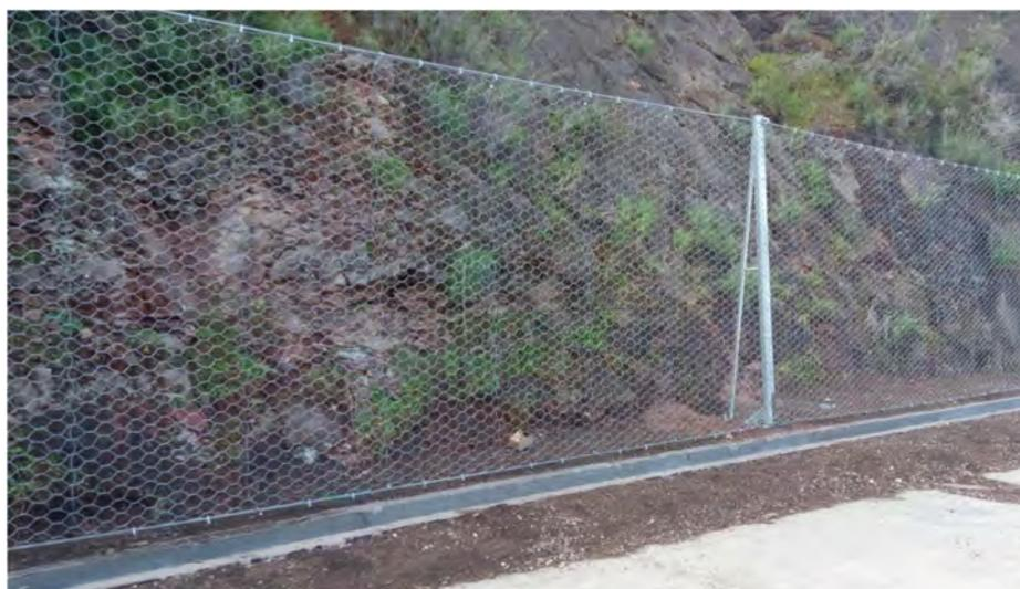
*Figura 10.3 – Esempio reti di protezione contro caduta massi.*
