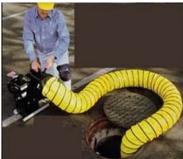
Figura 2.4 – Esempio d'intervento di ventilazione.
