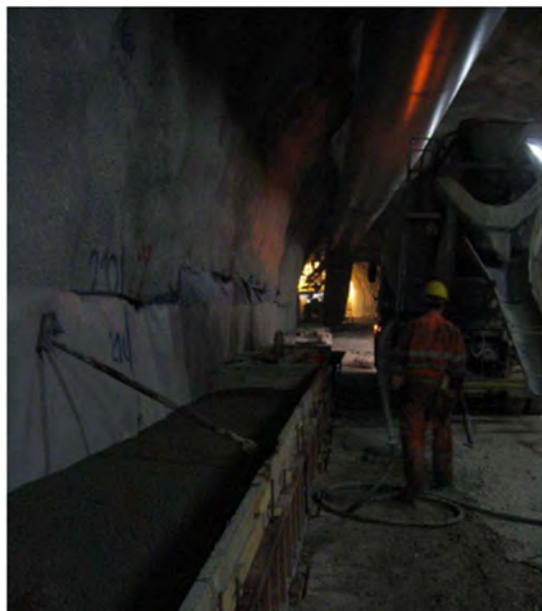
Figura 2.39 – Esempio fase realizzazione murette
