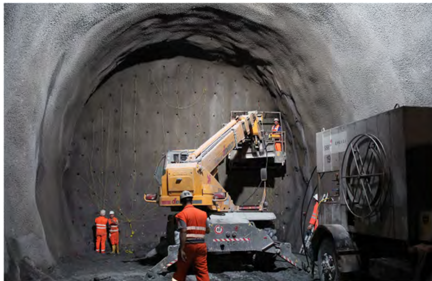
Figura 2.16 – Caricamento fori di volata
