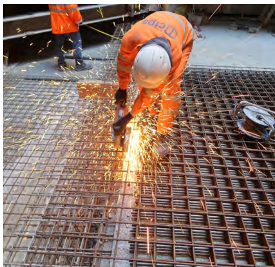
Figura 3.22 – Taglio e posa rete elettrosaldata
