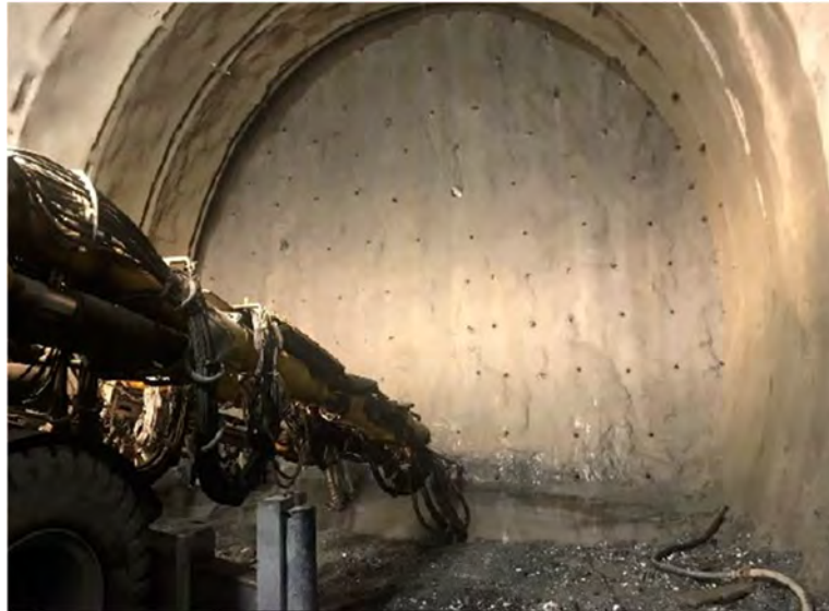
Figura 2.13 – Perforazione fori di volata
