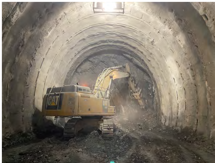
Figura 2.6 – Scavo con martellone
