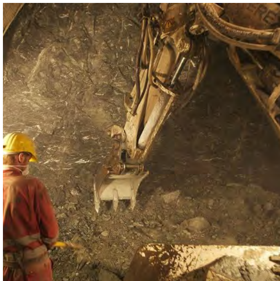
Figura 3.16 – Disgaggio
