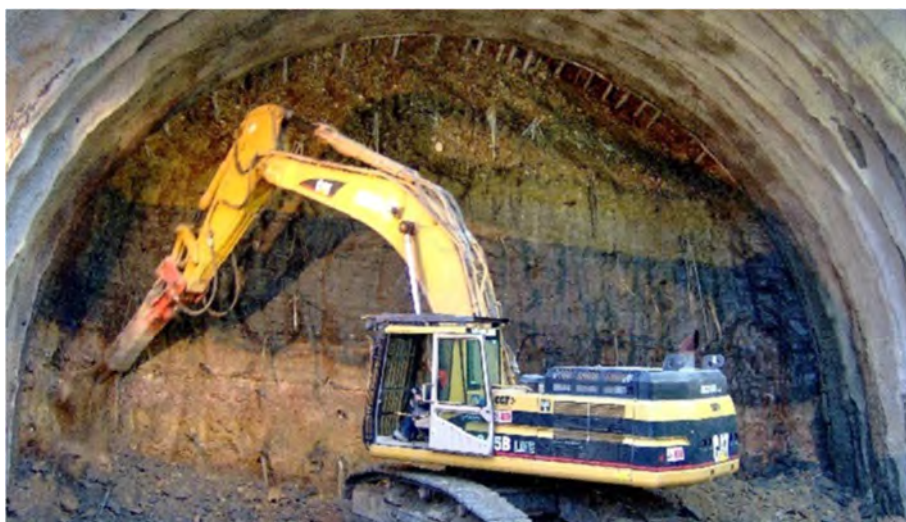
Figura 2.9 – Scavo con martellone idraulico montato su escavatore cingolato
