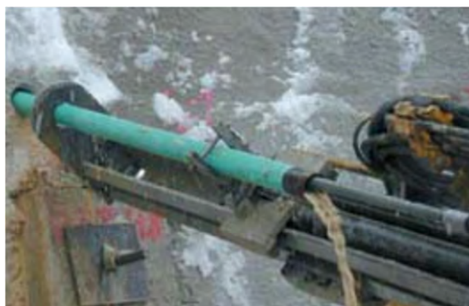
Figura 2.8 – Perforazione per inserimento tubi per consolidamento
