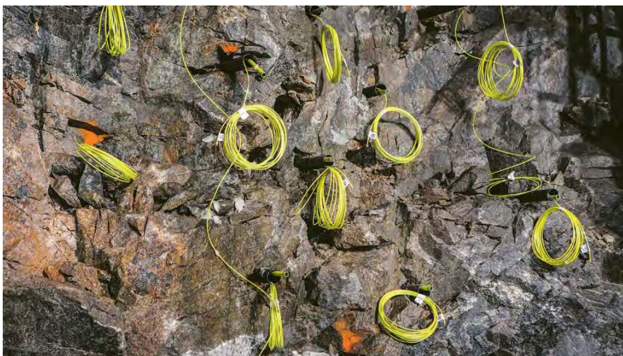
Figura 3.11 Caricamento fori di volata
