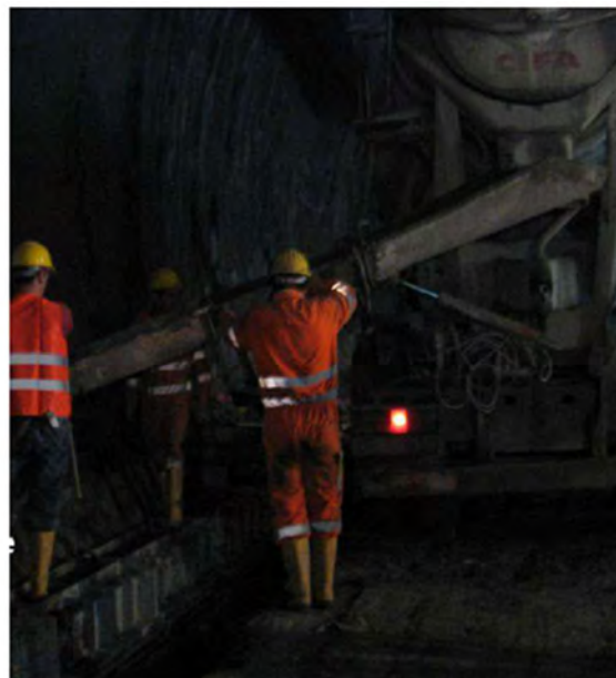
Figura 2.39 – Esempio fase realizzazione murette
