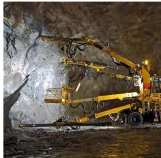
Figura 2.12 – Perforazione fori di volata
