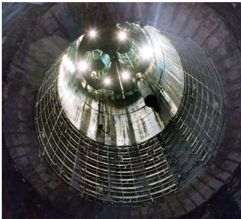
Figura 3.24 – Piattaforma in fase di discesa nel pozzo
