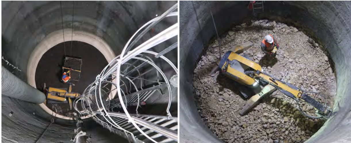
Figura 3.1 – Scavo con escavatore e trasporto smarino
