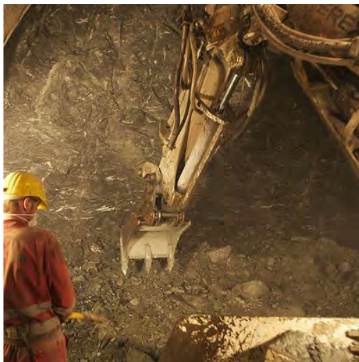
Figura 3.13 – Ispezione del fronte di sparo – rimozione dei detriti con martello disaggiatore
