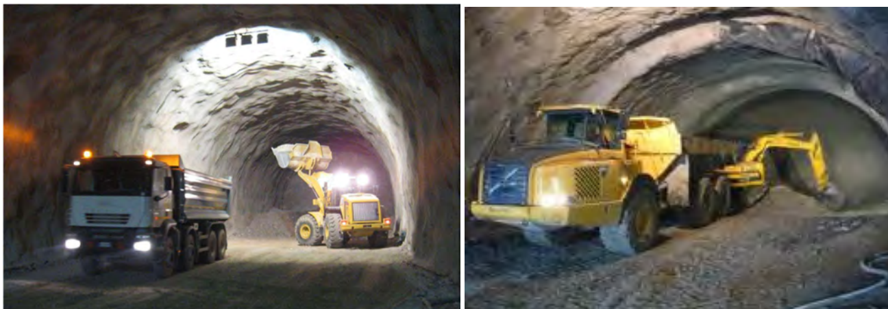
Figura 2.26 – Caricamento smarino
