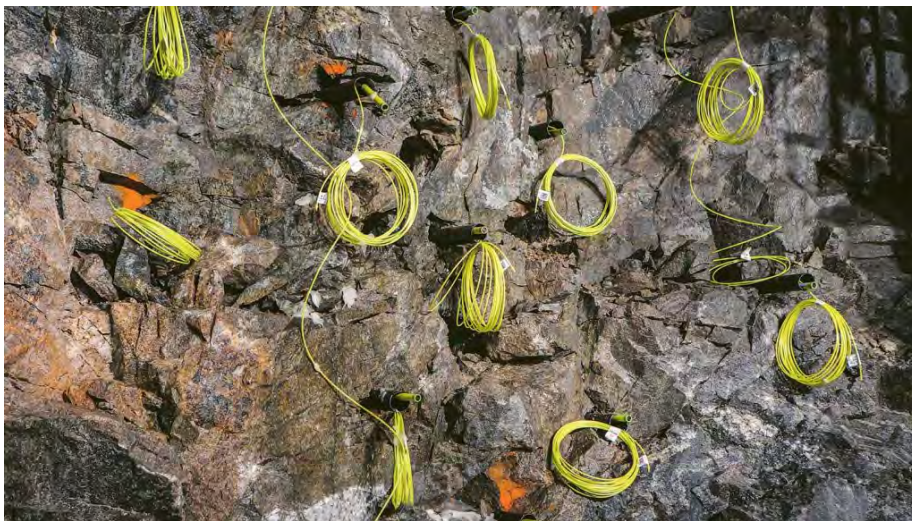
Figura 3.14 – a) Confezionamento ed innesco delle cariche e caricamento fori da mina
