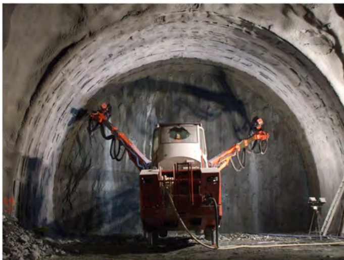
Figura 2.12 – Perforazione fori di volata
