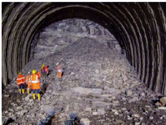
Figura 2.21 – Ispezione del fronte di sparo
