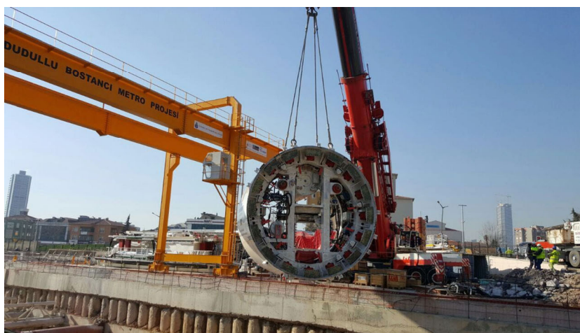
Figura 3.1 – Spostamento di elemento della TBM
