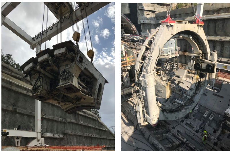
Figura 3.3 – Montaggio/smontaggio TBM
