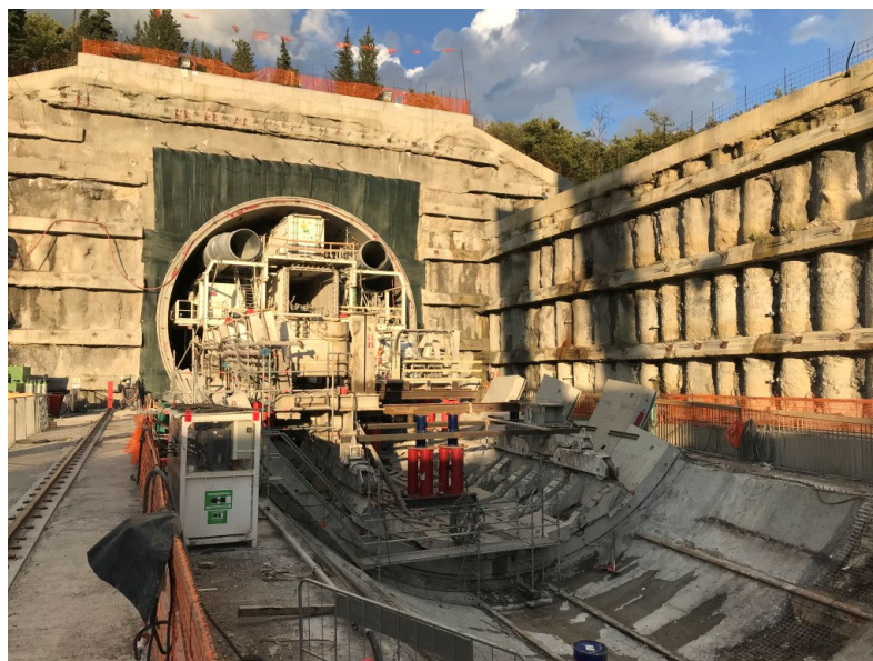
Figura 3.5 – Montaggio/smontaggio TBM
