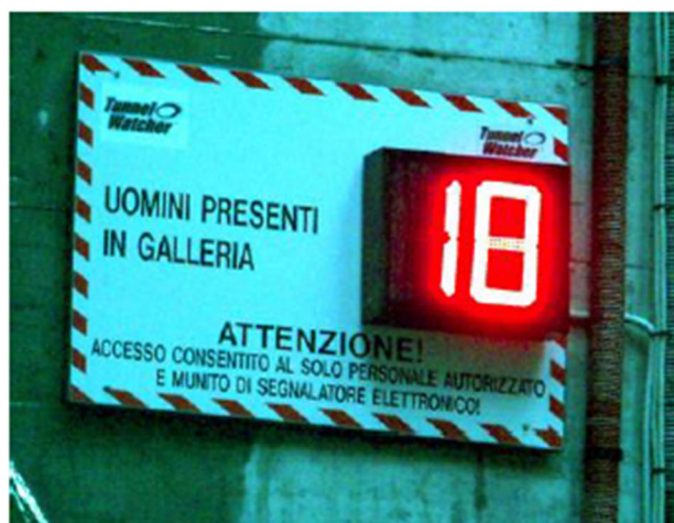
Figura 10.1 – Esempio di display da posizionare fuori gallerie e pozzi
