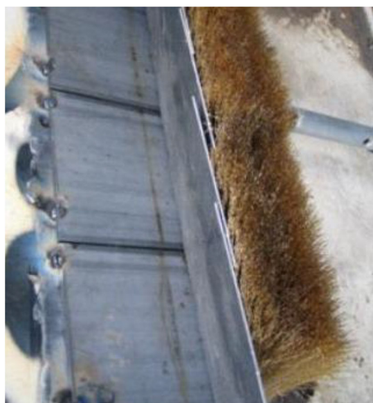
Figura 4.4 – Particolare spazzole di tenuta nella coda allo scudo della TBM
