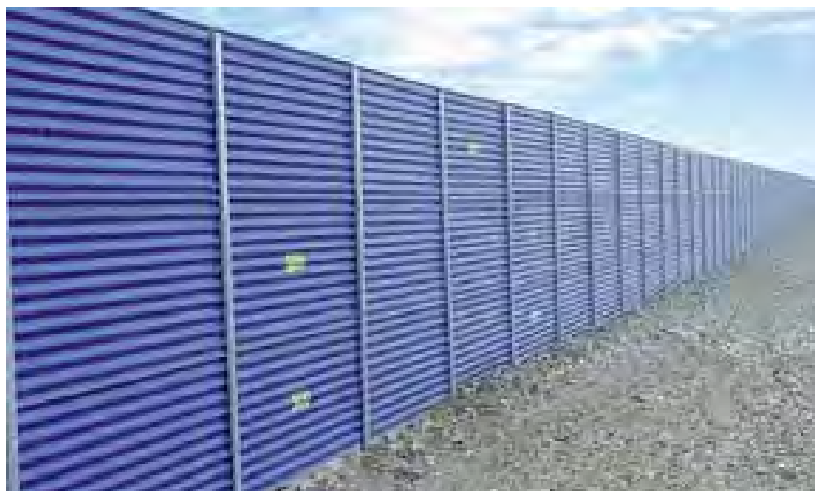
Figura 7.1 – Recinzione di cantiere
