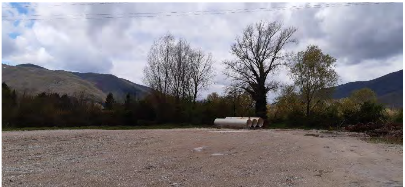
Figura 2.8 – Aree di cantiere M2
