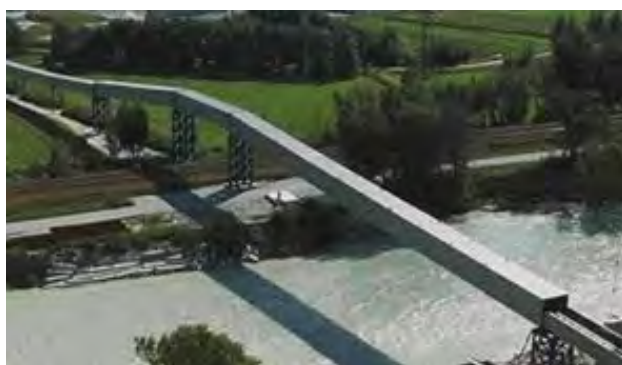
Figura 7.20 – Esempio di nastri trasportatori esterni per bordo strada e attraversamenti fluviali
