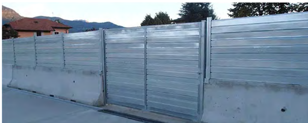
Figura 7.3 – Esempio cancello di cantiere
