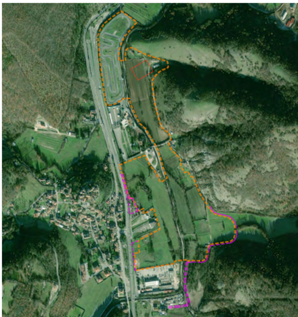
Figura 2.21 – Aree di cantiere San Giovanni Reatino SGR
