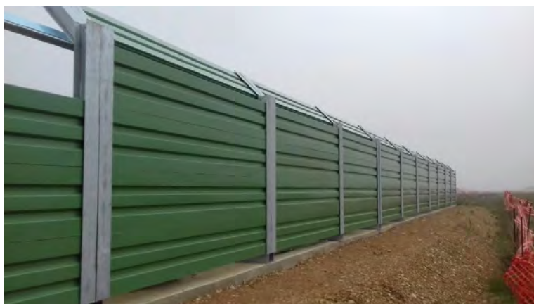
Figura 7.2 – Esempio Barriera antirumore
