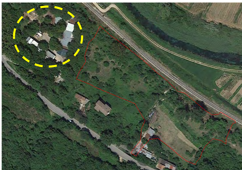
Figura 6.17 – Interferenza edifici esistenti presso uscita galleria Ponzano
