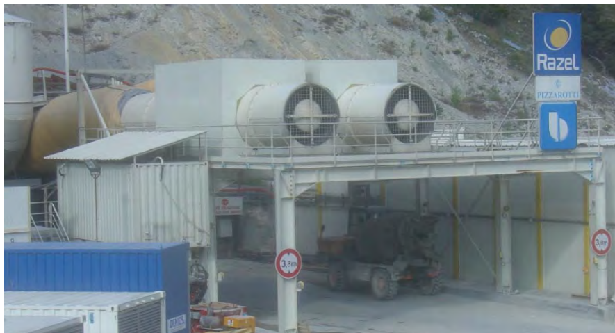
Figura 7.14 –Particolare dei silenziatori e carter di insonorizzazione dei motori
