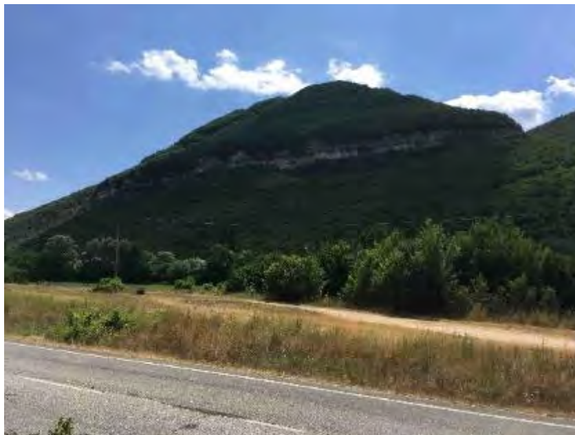
Figura 2.19 – Area di cantiere Turano Monte
