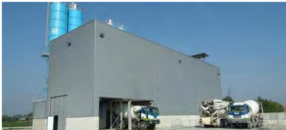
Figura 7.16 – Impianto di betonaggio
