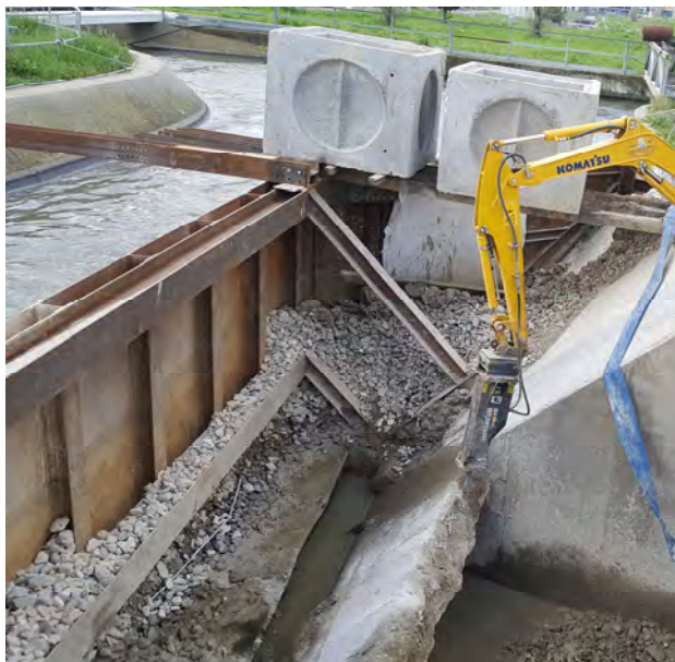
Figura 10.3 – Esempio di sbarramento metallico per realizzazione canale di collegamento
