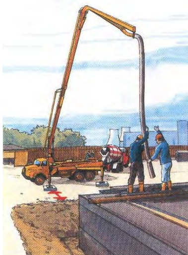
Figura : fase di getto del CLS
