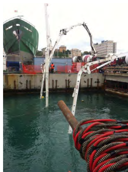
Figura 10.5 – Esempio getto cls in subacqueo
