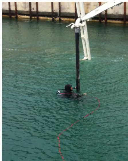
Figura 10.5 – Esempio getto cls in subacqueo
