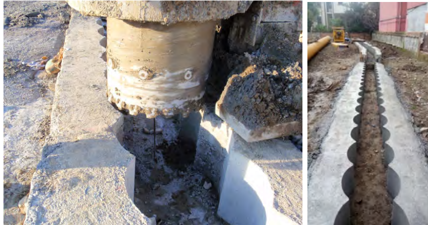
Figura 10.1- Esempio di correa con sagoma delle perforazioni
