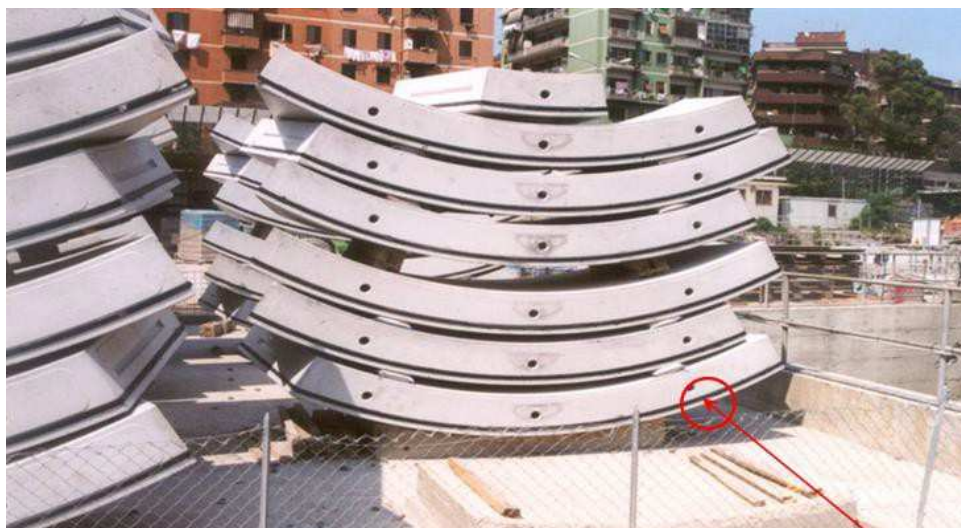
Magazzino conci con le guarnizioni di tenuta idraulica montate
