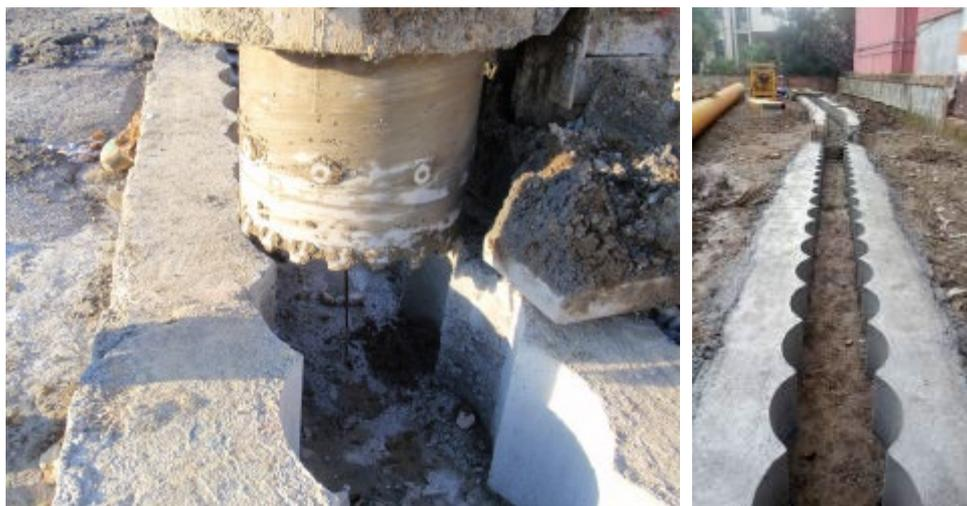
*Figura 7.3 - Esempio di correa con sagoma delle perforazioni*
