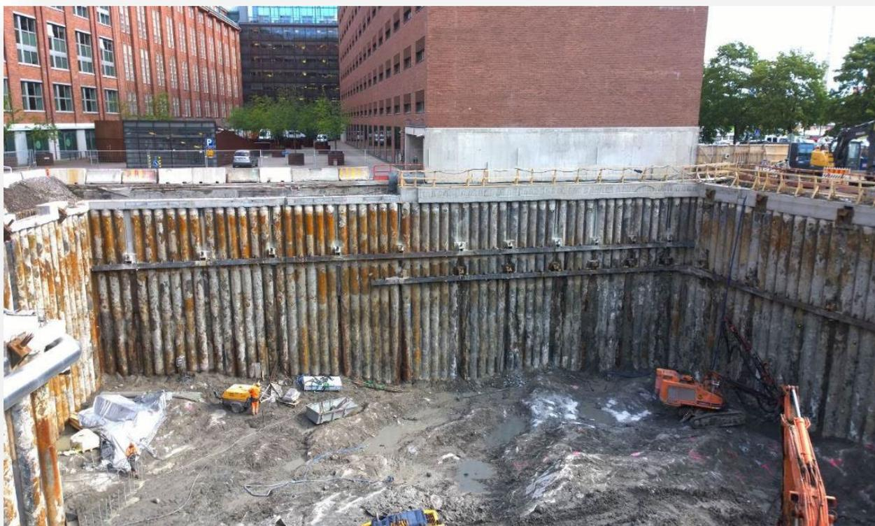
Figura 7.9 - Installazione dei pali interconnessi in un cantiere a Skanska, Helsinki
