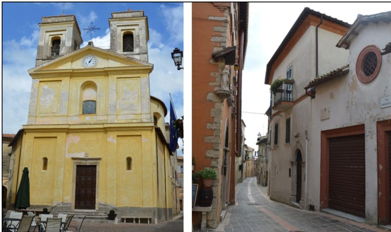
Figura 3.4.2.5h Chiesa dei SS. Pietro e Paolo – Viabilità del centro storico di Salisano
