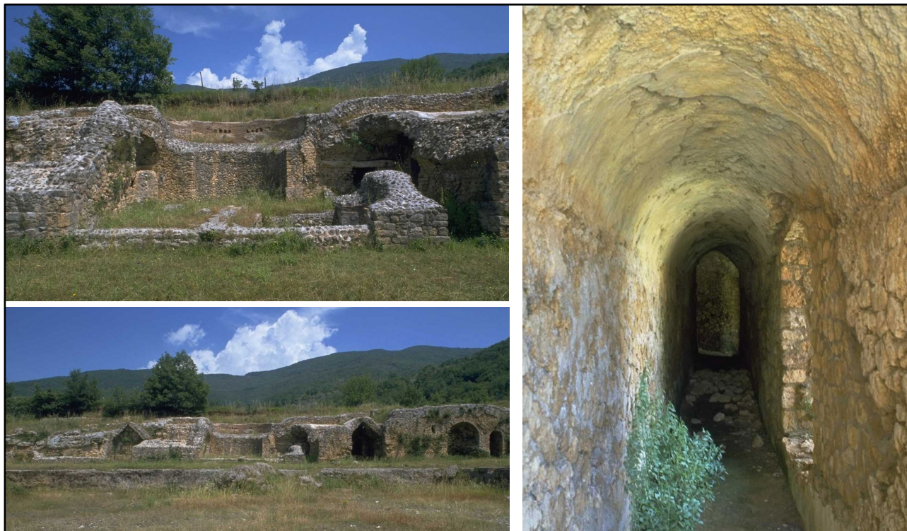
Figura 3.4.2.1h Resti archeologici delle Terme di Vespasiano – Prospetto Nord con corridoio
