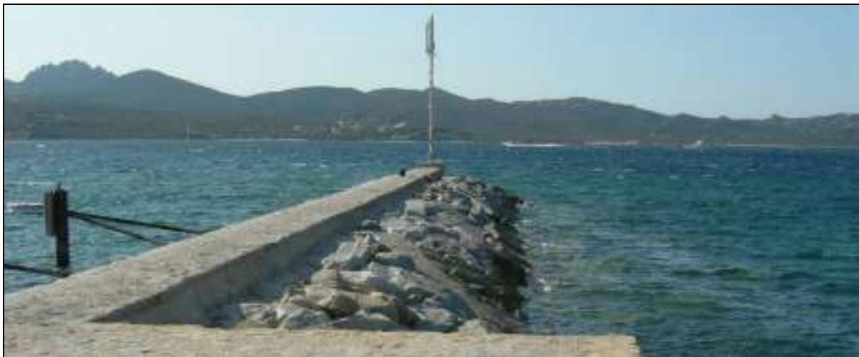
Foto 2 – Pennello da prolungare situato a Nord-Est dell'imboccatura portuale
