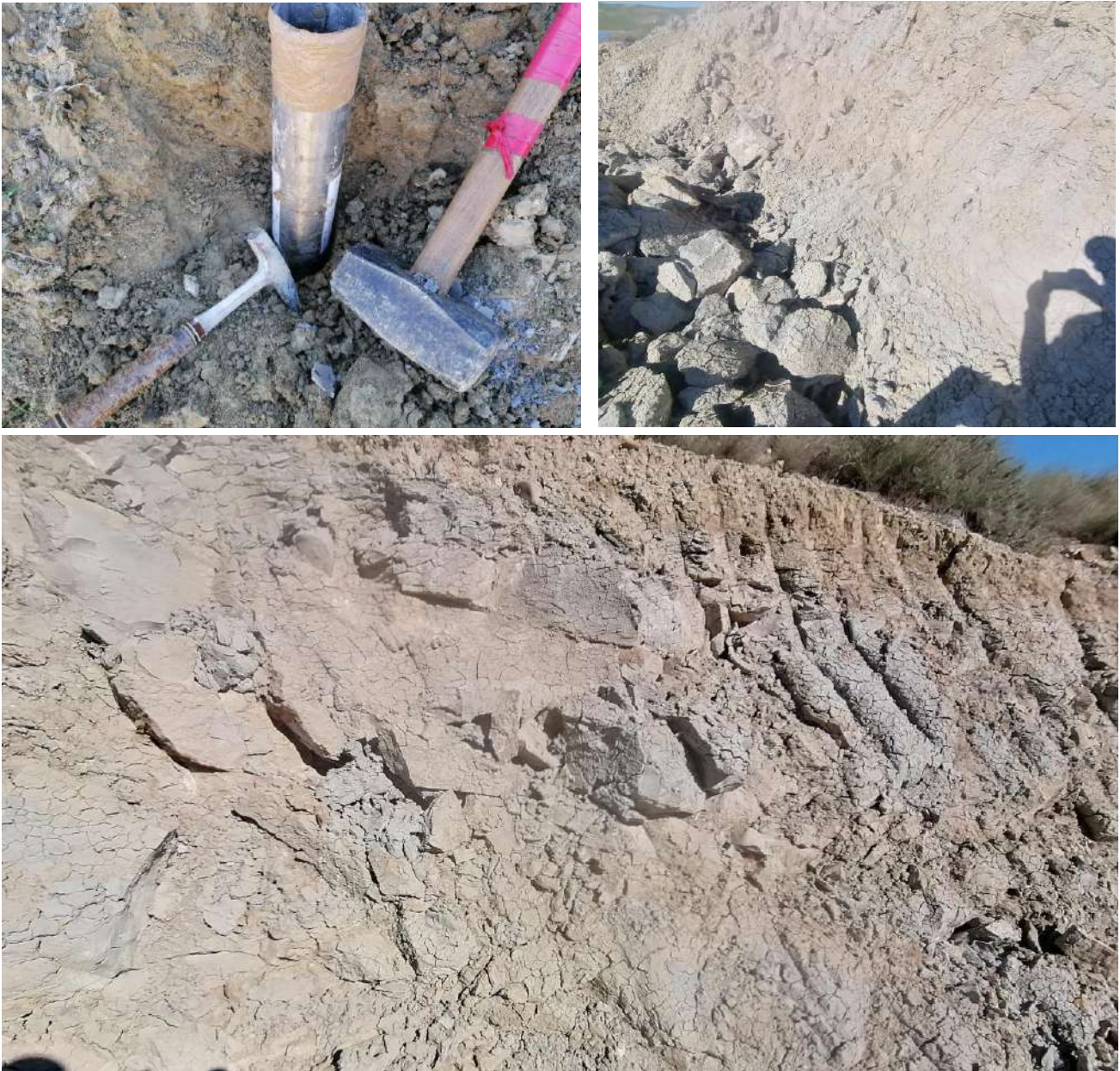
SCAVO E PRELIEVI ESEGUITI
