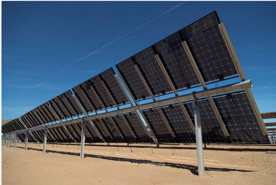
Figura 1 – vista prospettica inseguitore solare monoassiale
