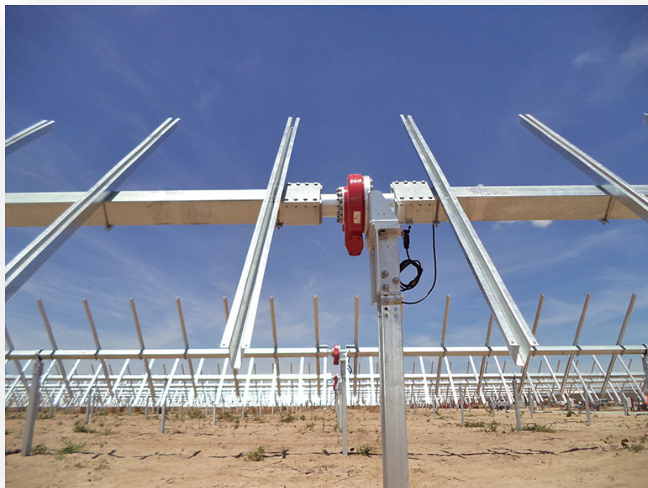
Figura 1 – vista prospettica inseguitore solare monoassiale
