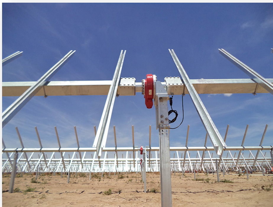
Figura 6 – vista prospettica inseguitore solare monoassiale
