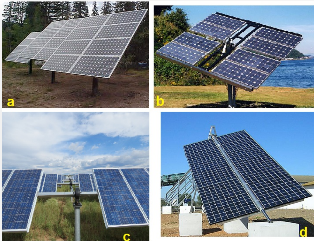
Figura 28 - Sistemi ad inseguimento: a) inseguitore di tilt, b) inseguitore di azimut, c) inseguitore di rollio, d) inseguitore ad asse polare.
