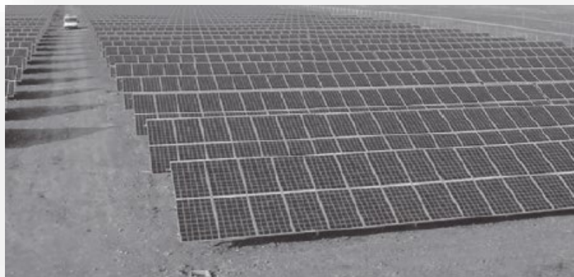
Figura 10 – Disposizione strutture fisse
