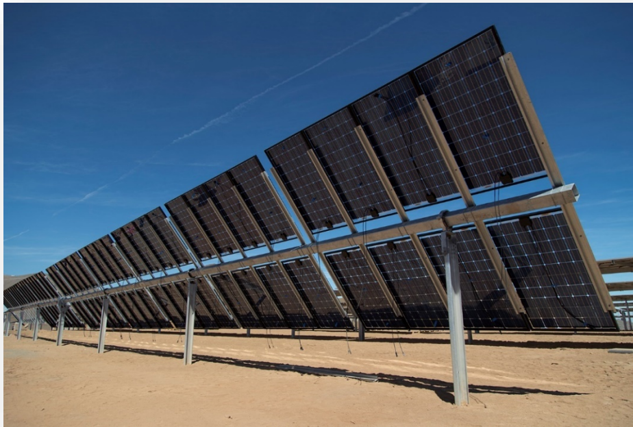
Figura 6 – vista prospettica inseguitore solare monoassiale
