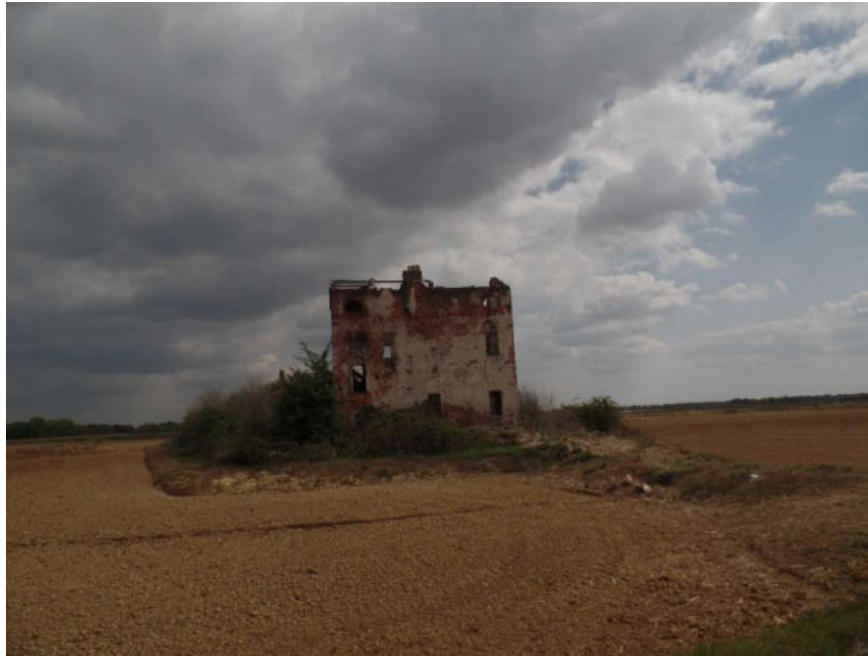
Figura 12: Visuale dell'edificio parzialmente diroccato situato nel settore centro-occidentale dell'area di intervento.
