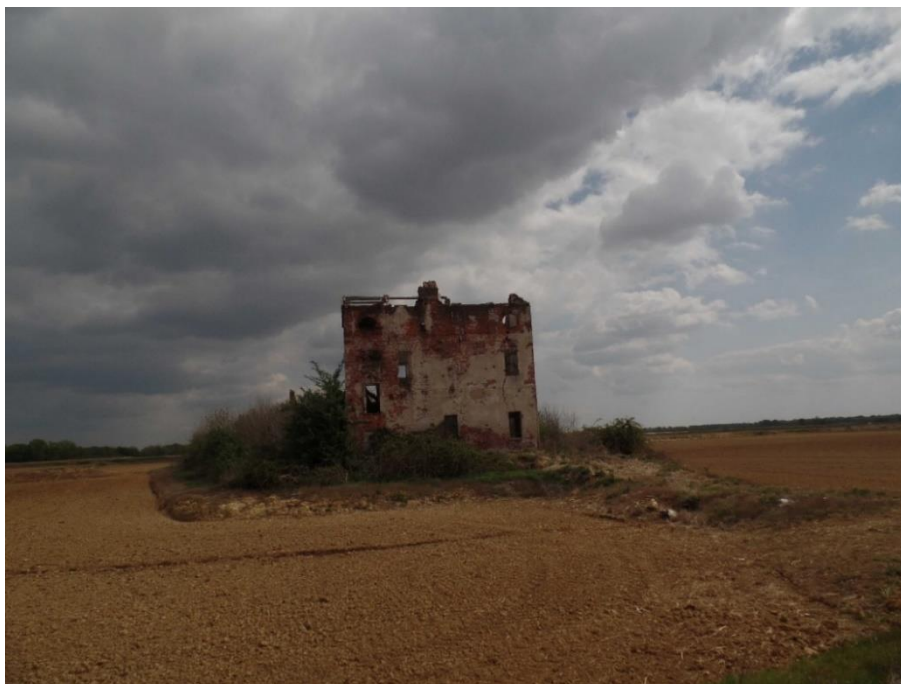
Figura 22: Visuale dell'edificio parzialmente diroccato situato nel settore centro-occidentale dell'area di intervento.
