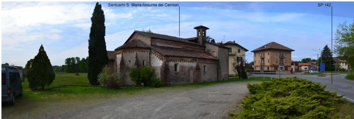
Foto 11 – Panoramica verso le aree di progetto dalle aree di pertinenza del Santuario di S. Maria Assunta dei Cerniori in Curavecchia. Le aree di progetto non risultano visibili.
