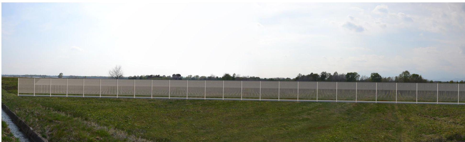
Figura 15 - Stato di progetto senza gli interventi di mitigazione e compensazione per l'inserimento paesaggistico-ambientale. L'immagine mostra l'area di intervento al termine dell'installazione degli elementi tecnologici per la produzione di energia elettrica rinnovabile.
