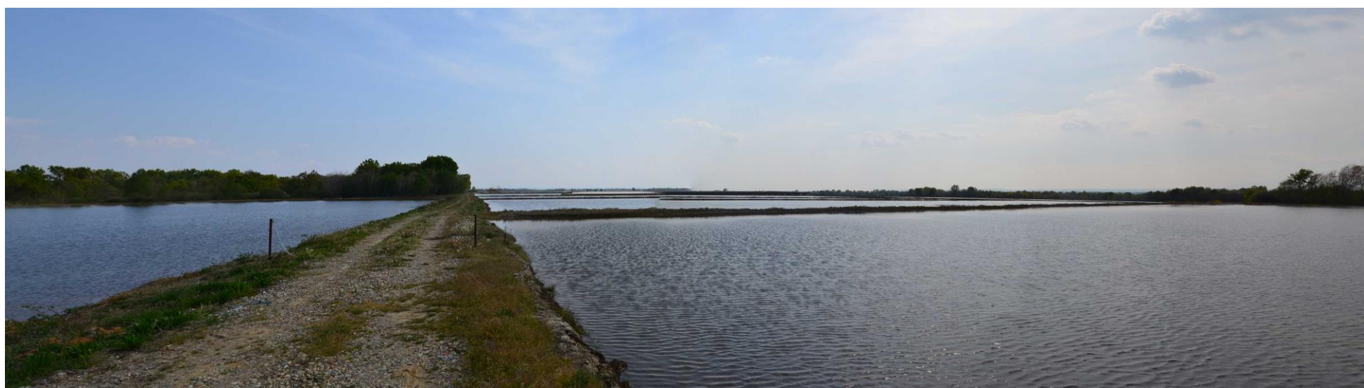
Figura 11 - Stato di progetto senza gli interventi di mitigazione e compensazione per l'inserimento paesaggistico-ambientale. L'immagine mostra l'area di intervento al termine dell'installazione degli elementi tecnologici per la produzione di energia elettrica rinnovabile. Questi, a causa della significativa distanza, risultano scarsamente visibili.
