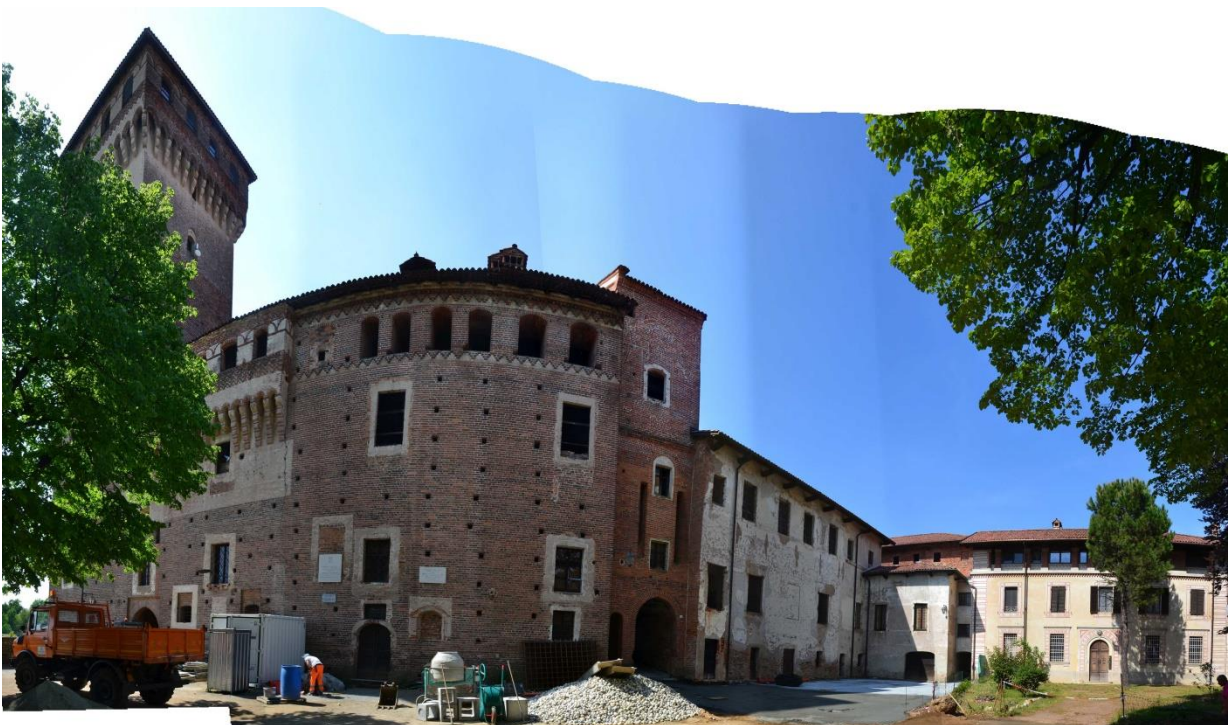
Foto 44 – Panoramica in direzione nord, verso le aree di progetto, dal castello di Rovasenda. Le aree di progetto non risultano visibili.
