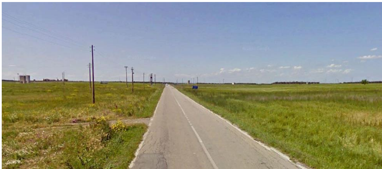
Figura 4-54: Strada Provinciale SP82 in prossimità dell'impianto
