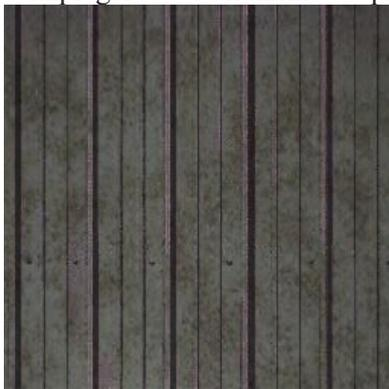
**Figura 1.3: Particolare copertura in alluminio preverniciato**
