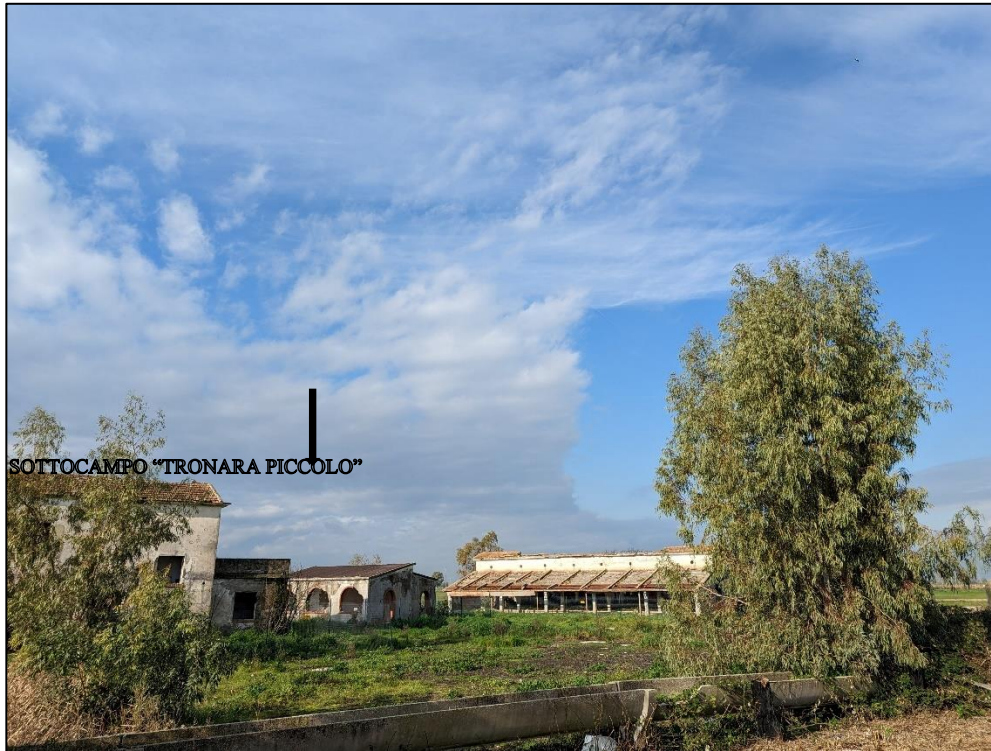
Figura 37: FOTO 9 – vista da via Bonifica verso il sottocampo “Tronara Piccolo”
