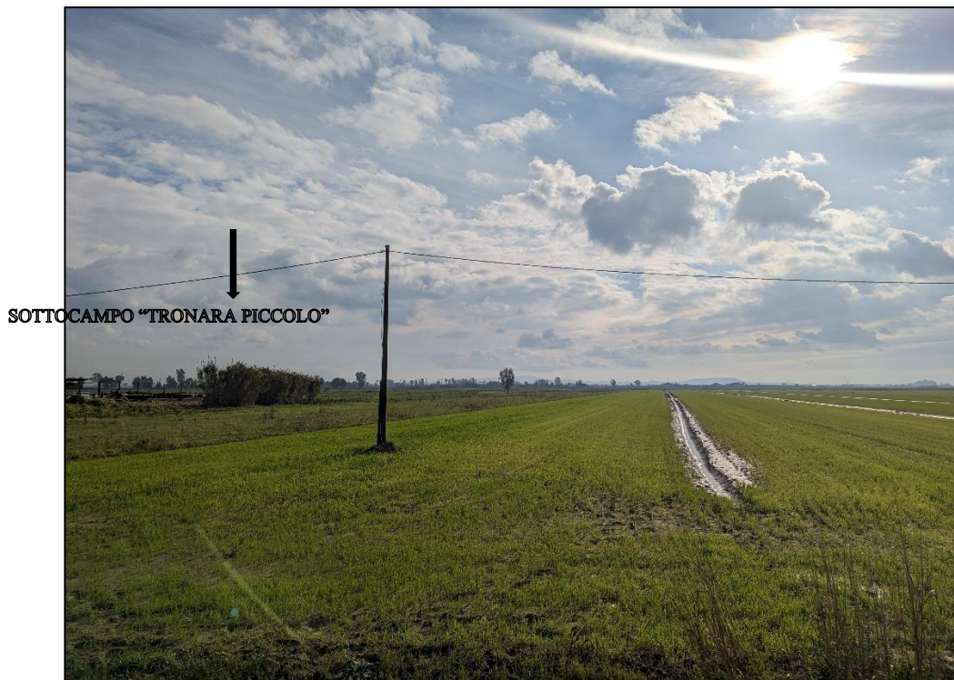
Figura 35: FOTO 7 – vista da SP 190 verso il sottocampo "Tronara Piccolo"
