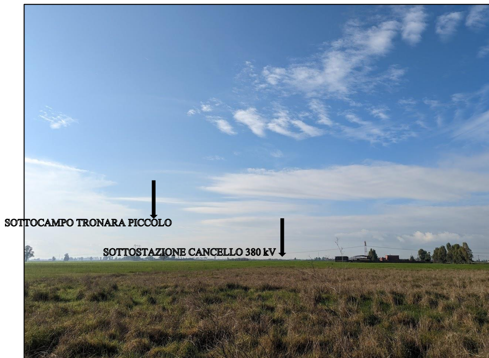
Figura 49: FOTO 21 – Vista stazione SE Canello 380 kV in direzione del sottocampo “Tronara Piccolo”
