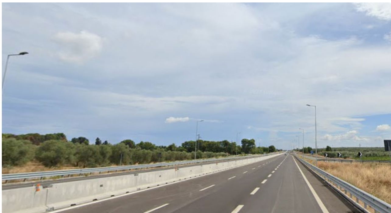
Figura 4 – Tratto di cavidotto interessato dall'interferenza con il "Tratturello Via Traiana" coincidente con Strada Provinciale SP 231
