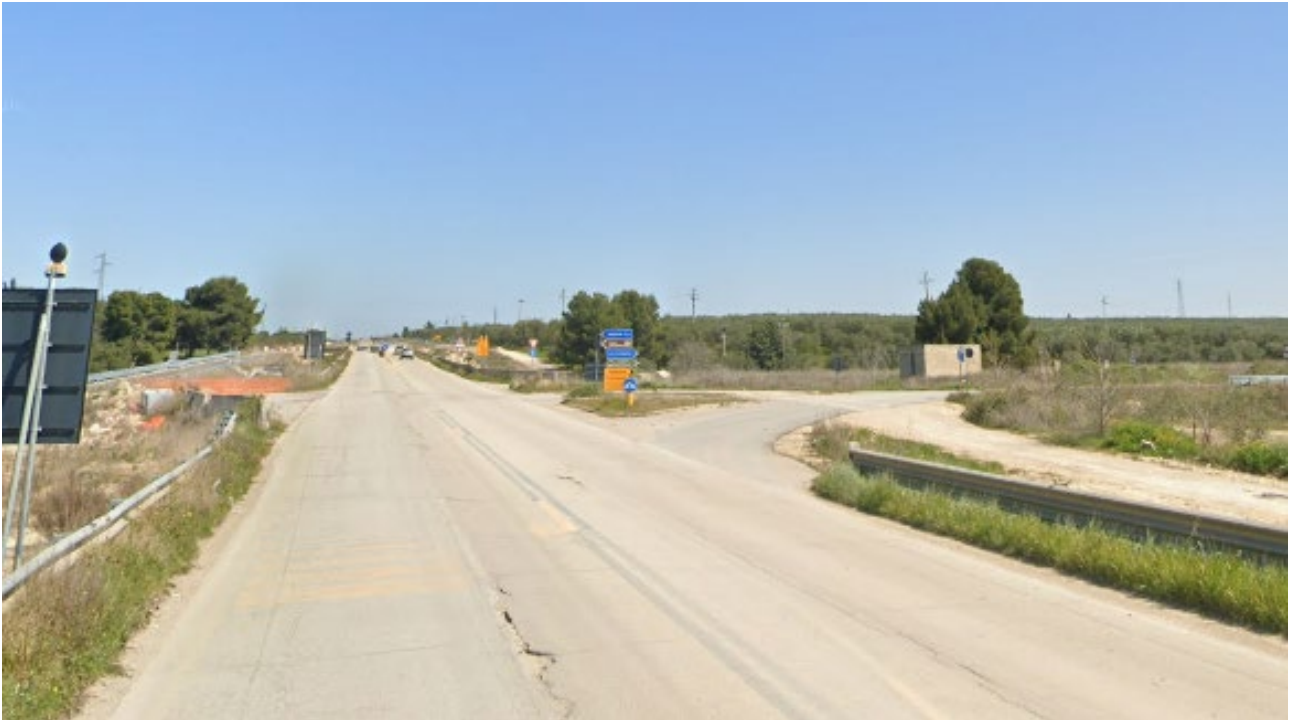
Figura 6- Tratto di cavidotto interessato dall'interferenza con il "Tratturello Via Traiana" coincidente con Strada Provinciale SP 231
