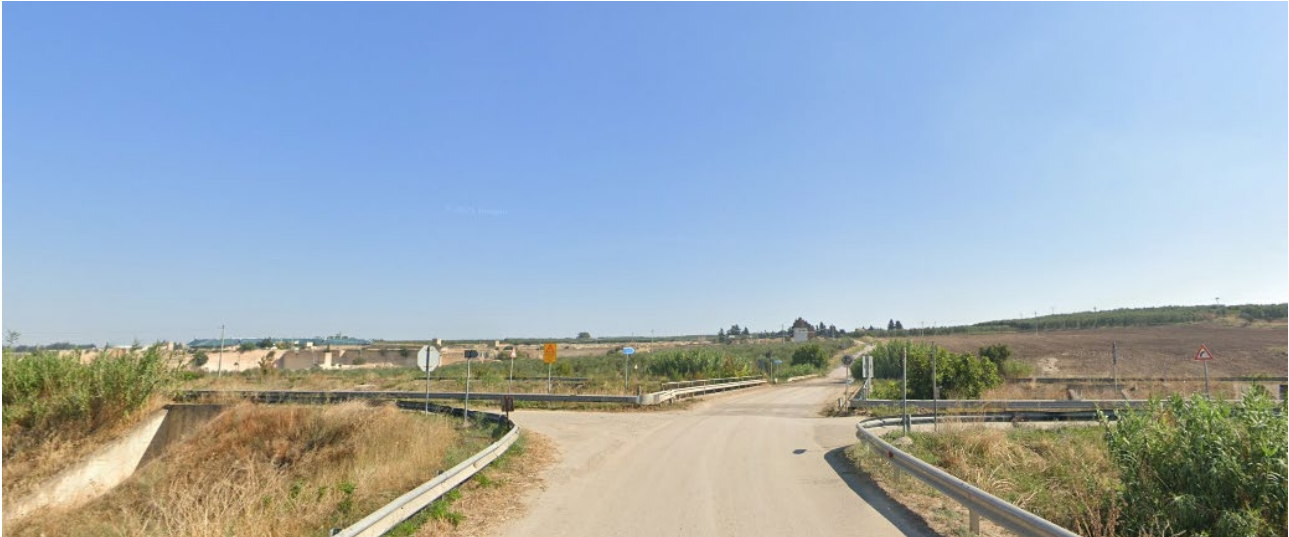
Figure 3 a/b – “Strada Provinciale 24” in corrispondenza dell’attraversamento “Torrente Locone”
