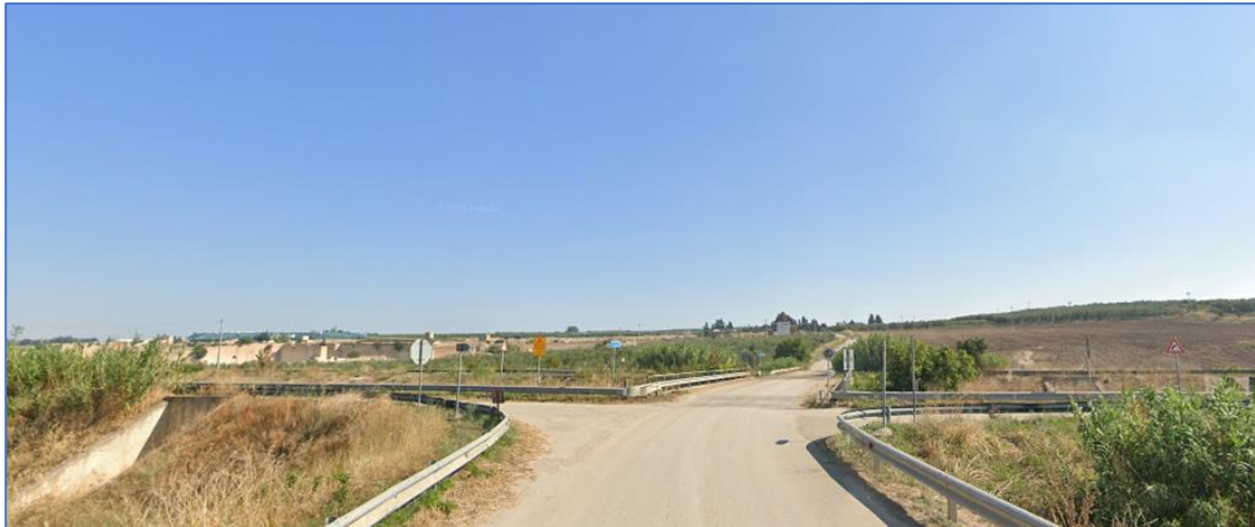
Figura 11 - "Strada Provinciale 24" in corrispondenza dell'attraversamento "Torrente Locone
