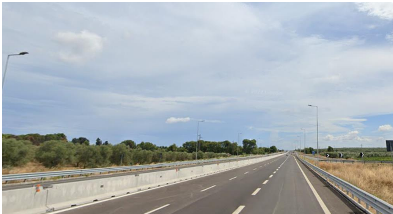
Figura 7 - Tratto di cavidotto interessato dall'interferenza con il "Tratturello Via Traiana" coincidente con Strada Provinciale SP 231
