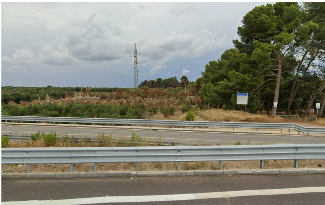
Stato di fatto – Punto di presa fotografica 12
