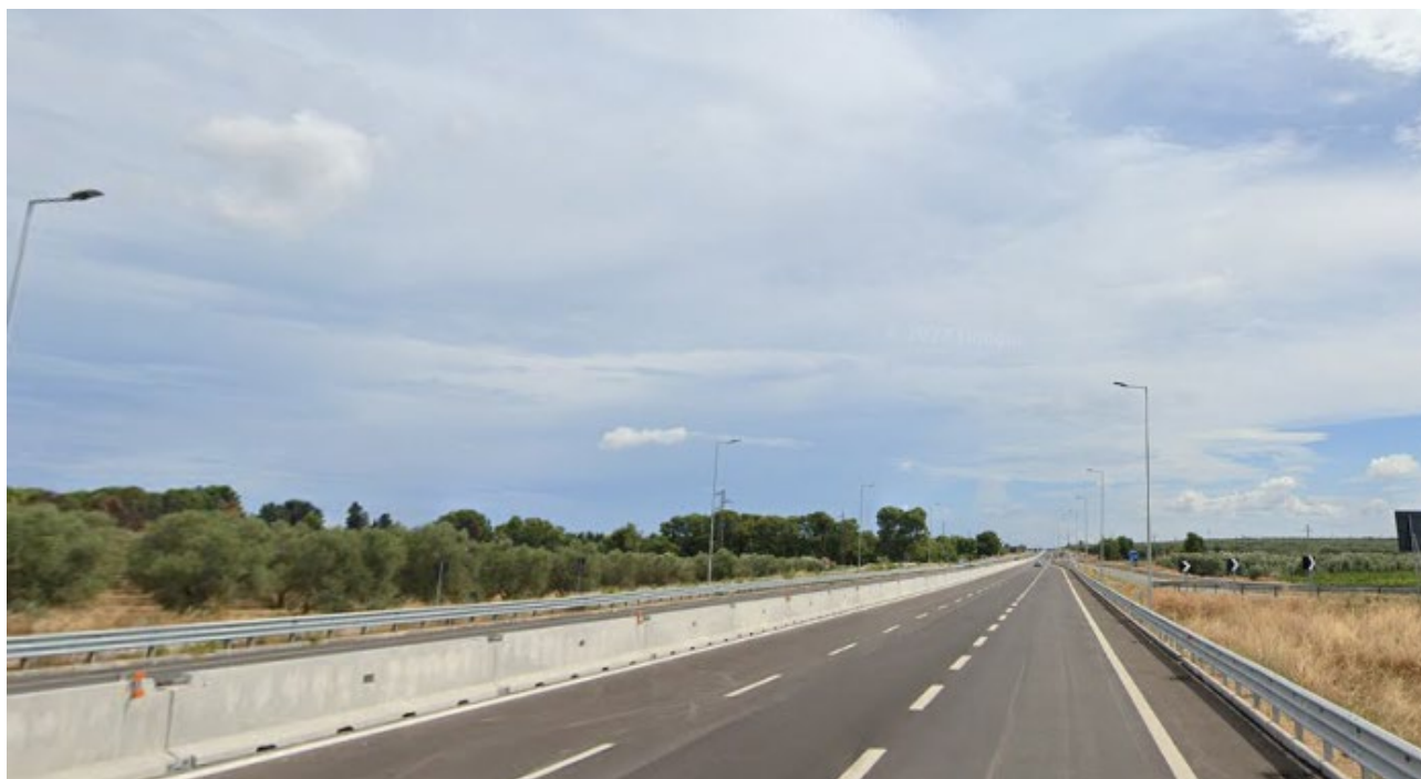
Figura 5 – Tratto di caviodotto interessato dall'interferenza con il "Tratturello Via Traiana" coincidente con Strada Provinciale SP 231
