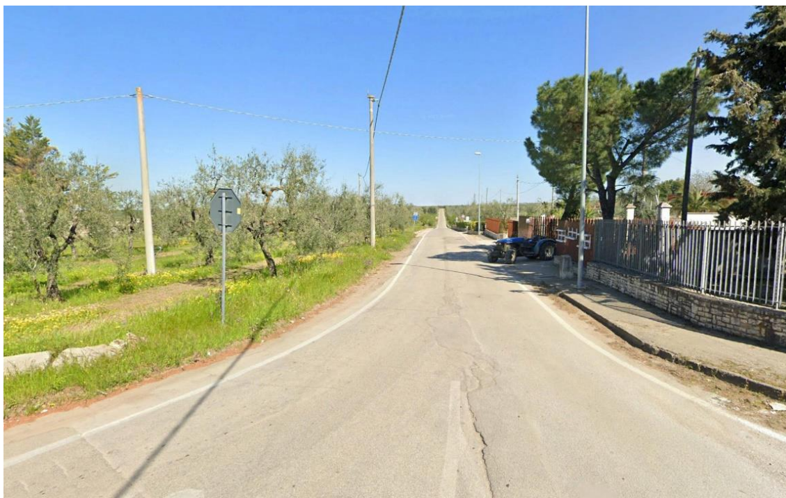
Stato di fatto – Punto di presa fotografica 13A
