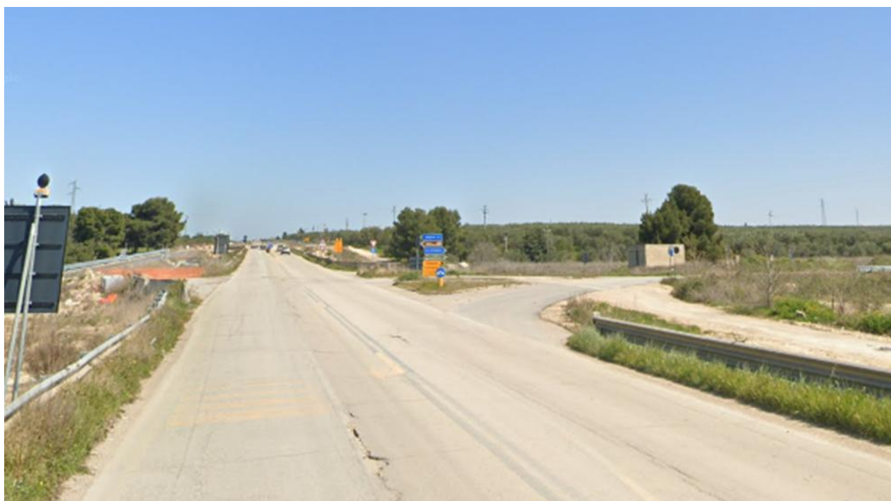
Figura 7 - Tratto di cavidotto interessato dall'interferenza con il "Tratturello Via Traiana" coincidente con Strada Provinciale SP 231
