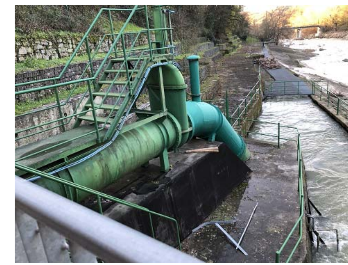
Tubazione esistente - Valvola a saracinesca
