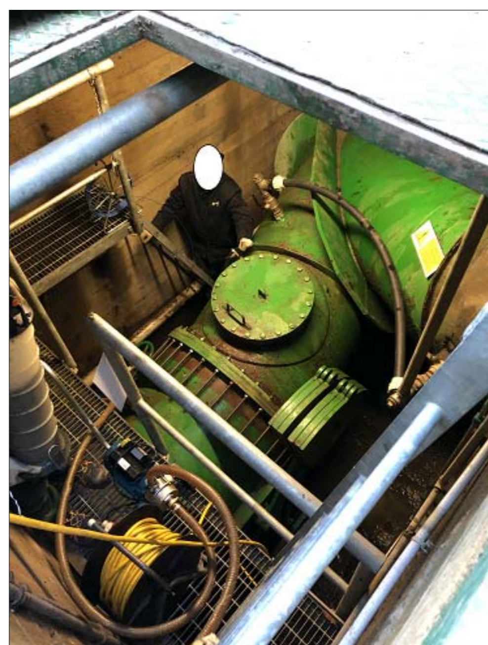
Diramazione by-pass esistente
