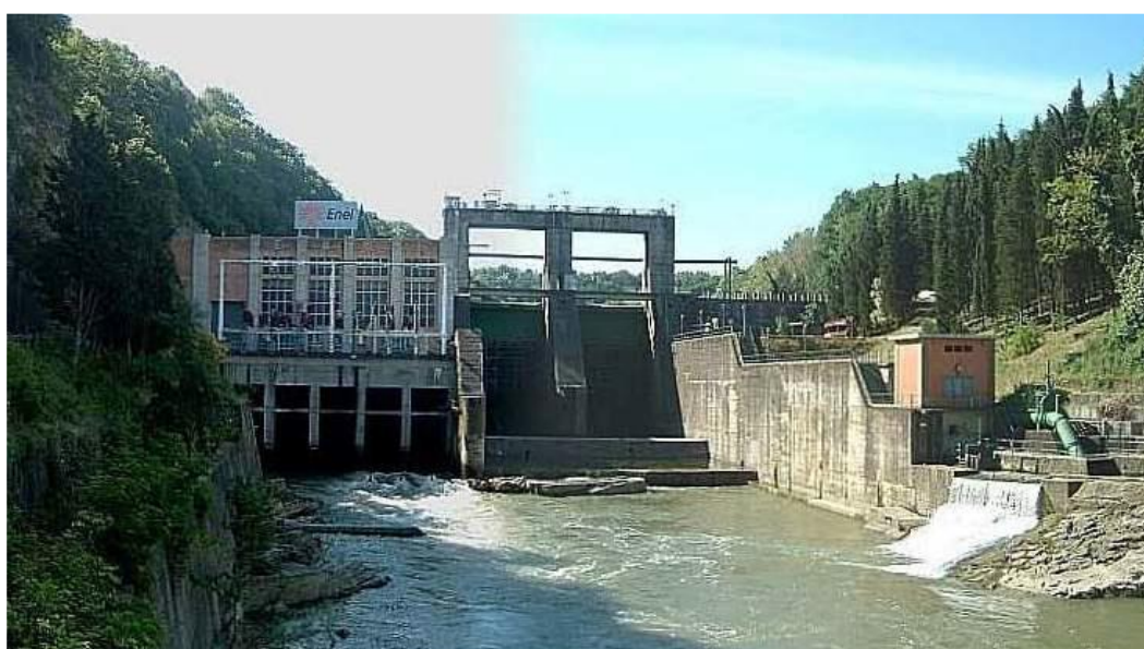
Figura 1.1 – Vista da valle dello sbarramento di Levane (foto ENEL).
