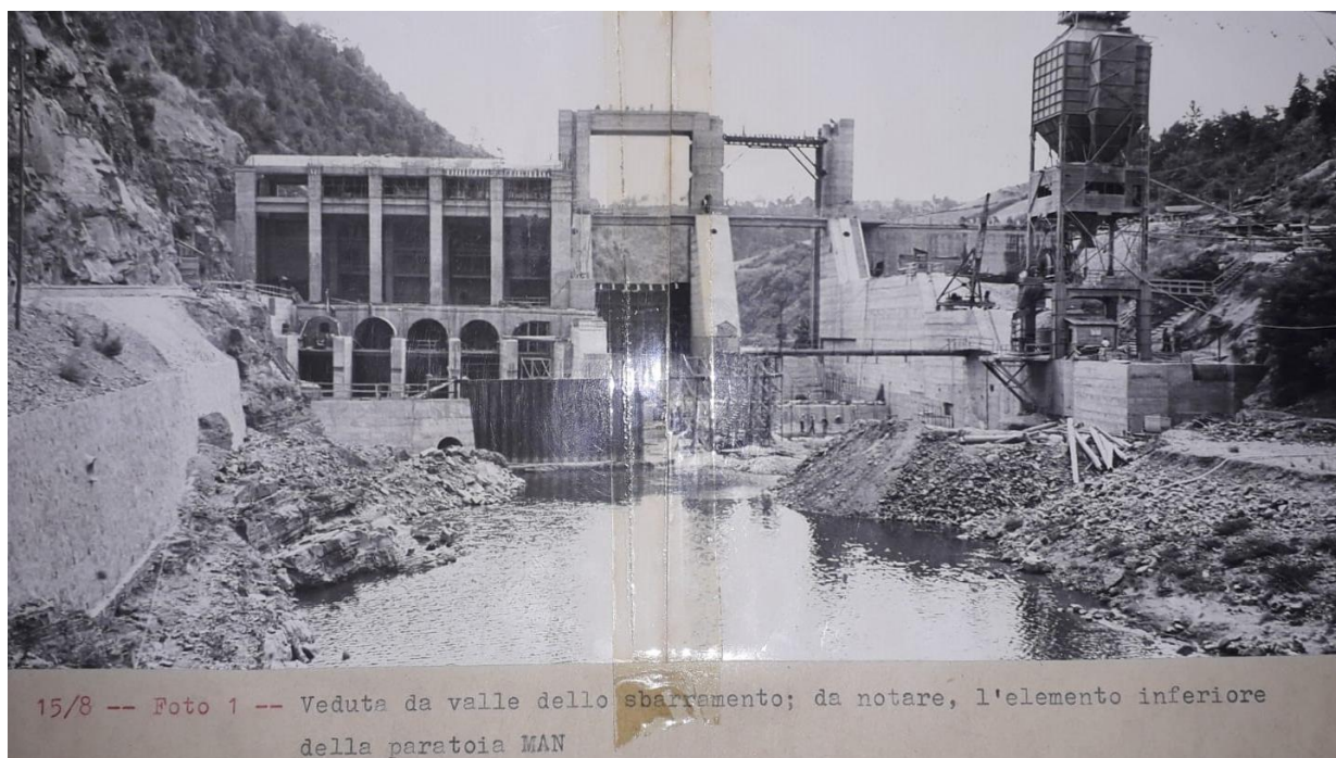
Figura 6.27 – Vista da valle dello sbarramento. Si notano la palancoata, affioramenti di roccia in destra idrografica ed i riporti di materiali in sinistra idrografica addossati al muro d'ala.
