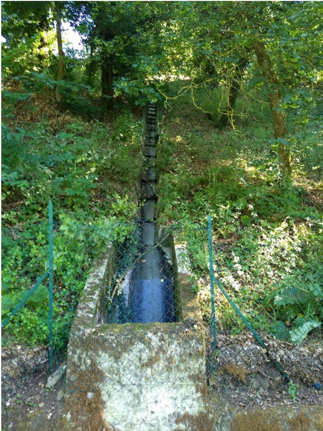
Figura 11.10 - Canale artificiale in prossimità della curva n. 1.
