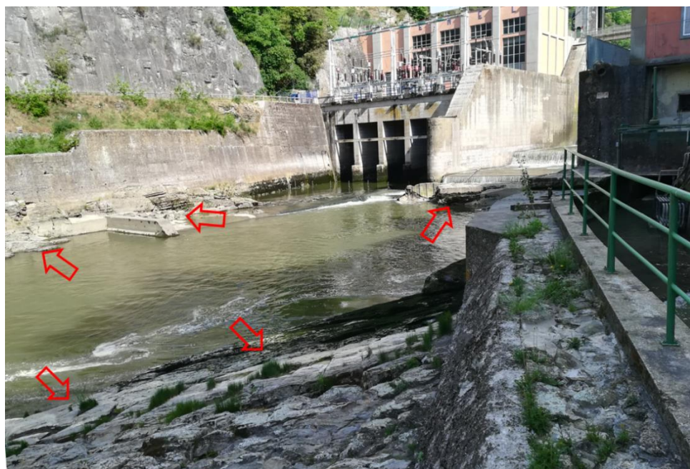
Figura 6.20 – Presenza di substrato roccioso affiorante (freccie rosse) immediatamente a valle dello sbarramento.
