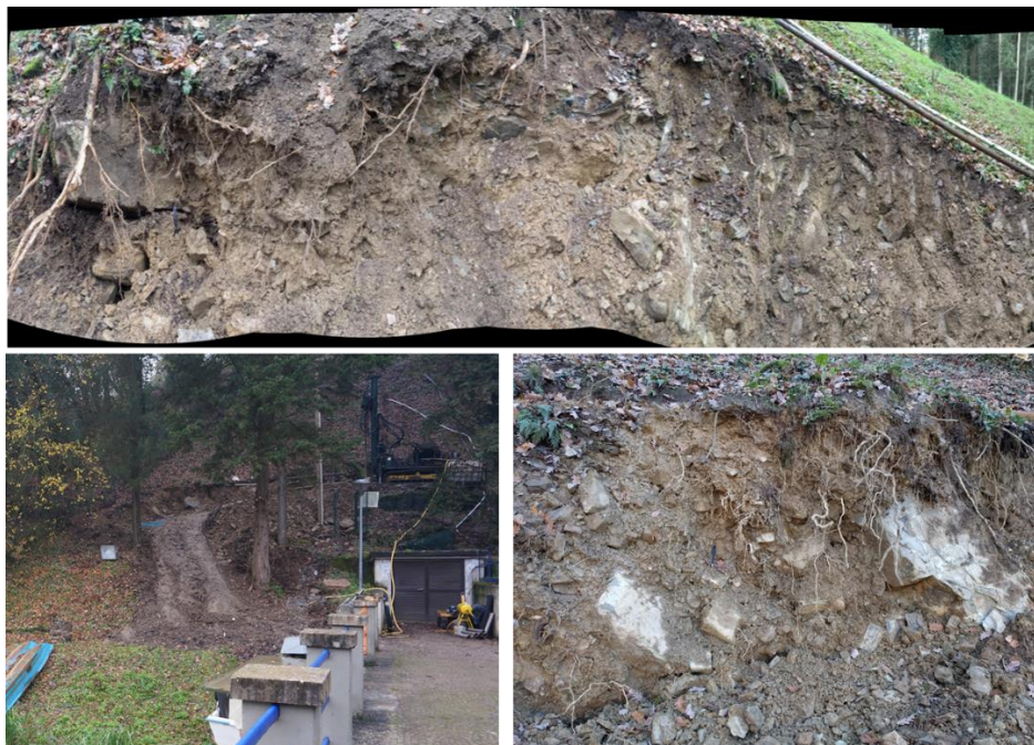
Figura 6.4 – Dettagli dello scavo della piazzola del sondaggio SS1 e della relativa pista di accesso.
