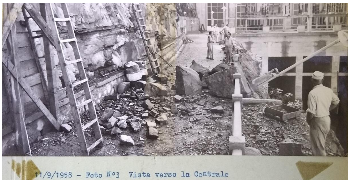
Figura 11.6 – Probabile crollo durante le lavorazioni di costruzione dell'impianto.
