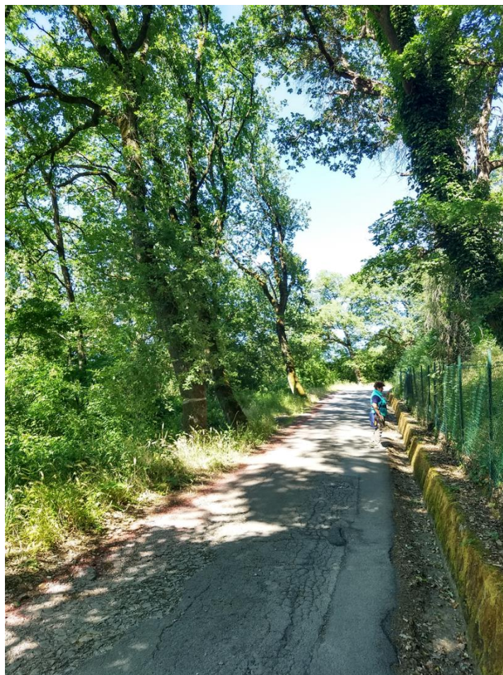
Figura 11.11 – Alberi inclinati verso valle lungo la banchina stradale.
