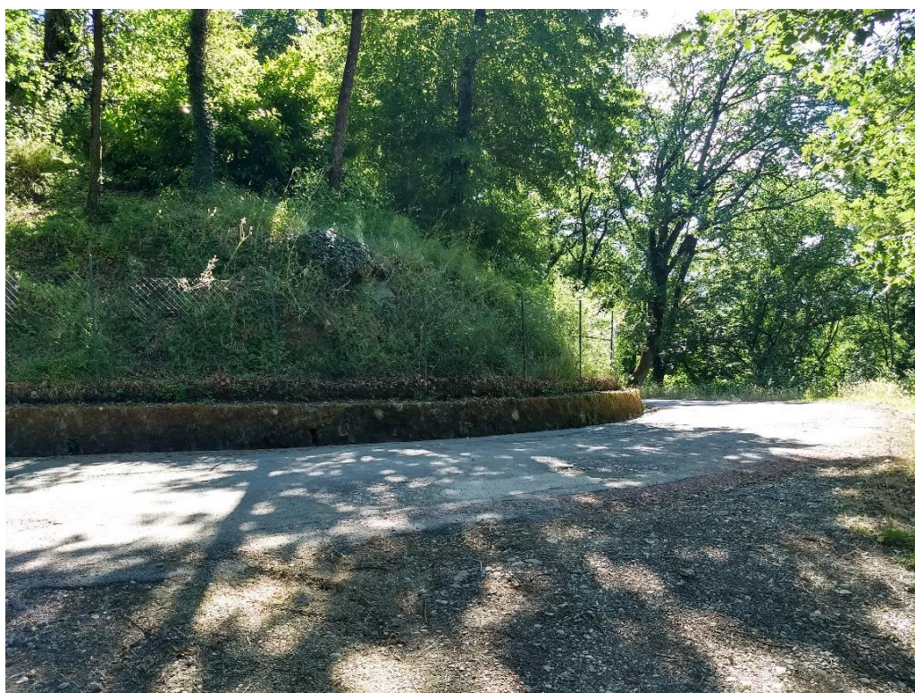
Figura 11.13 - Particolare della curva n. 2 vista da monte.
