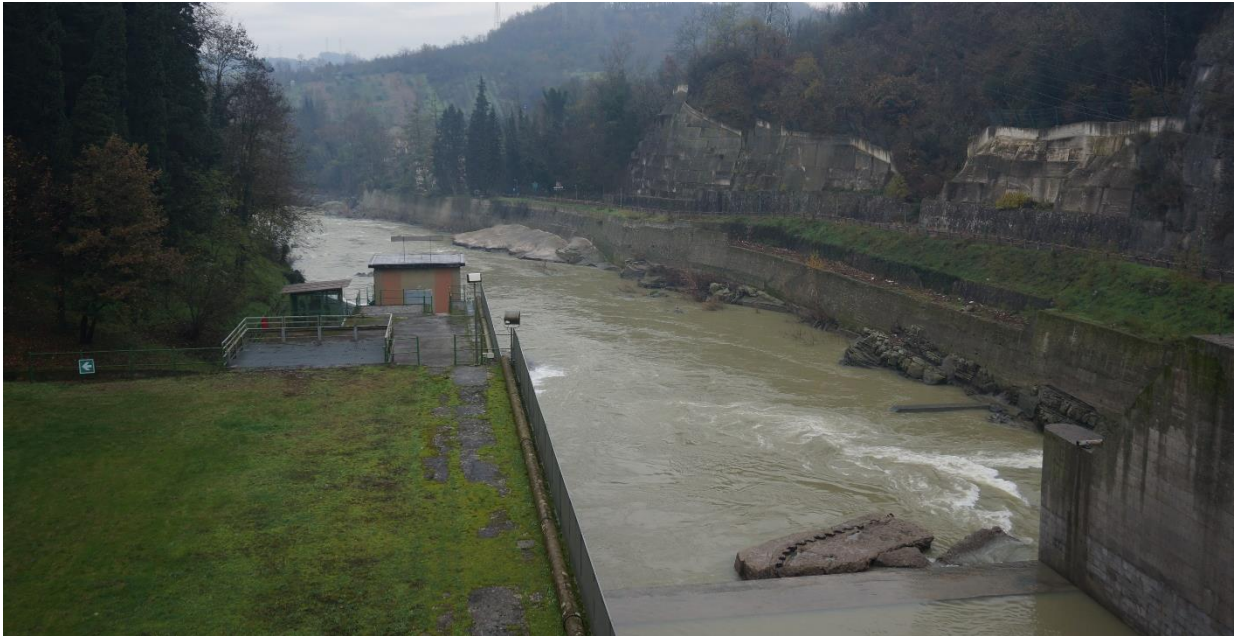
Figura 6.19 – Vista dell'alveo di valle dallo sbarramento.
