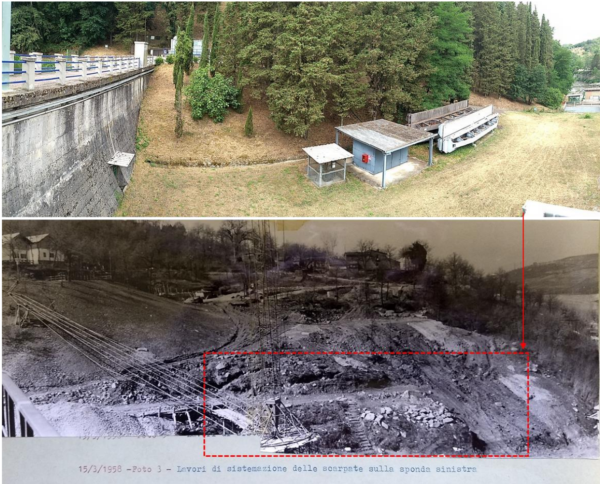
Figura 6.12 – Vista della sponda sinistra durante la fase di cantiere (in basso) e dettaglio dell’attuale morfologia (in alto).
