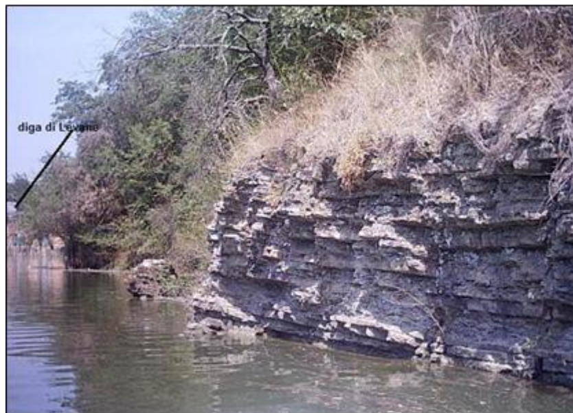
Figura 2 - Affioramento di AMF versante destro a monte diga [A5]
