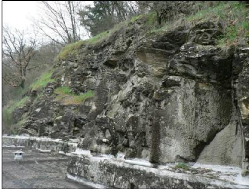
Figura 1 - Affioramento di AMF, versante destro sopra la centrale [A1]
