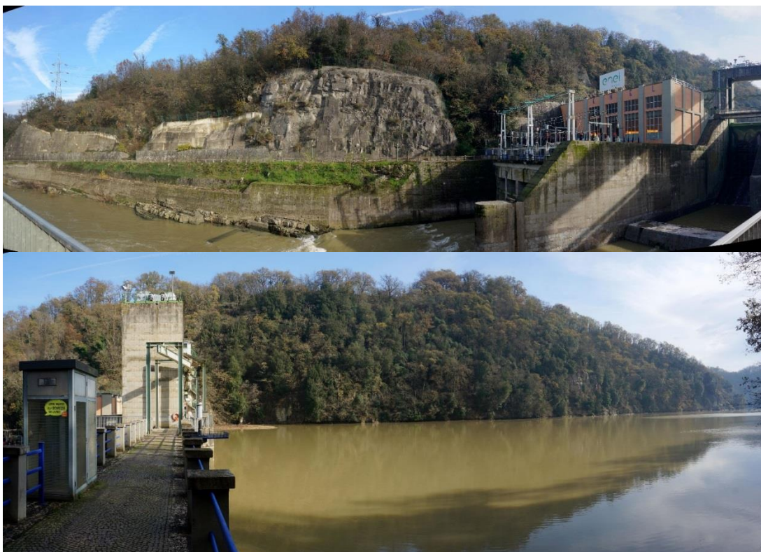
Figura 7 – Viste panoramiche di valle (in alto) e di monte (in basso) del versante destro
