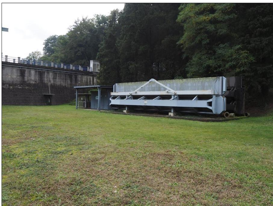
**Foto 13: cabina MT e struttura di movimentazione panconi sul piazzale a q.161m s.l.m.**
