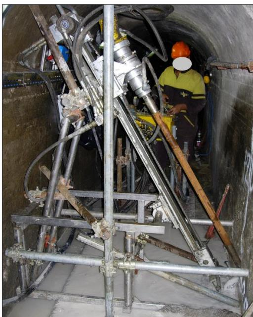
**Figura 30: tipologico carotatrice rotativa smontabile all'interno di un cunicolo**
