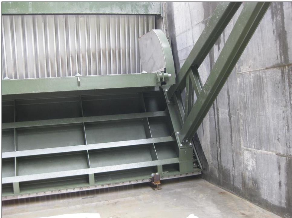
**Foto 11: tipologico di un sistema con panconatura ad aghi**
