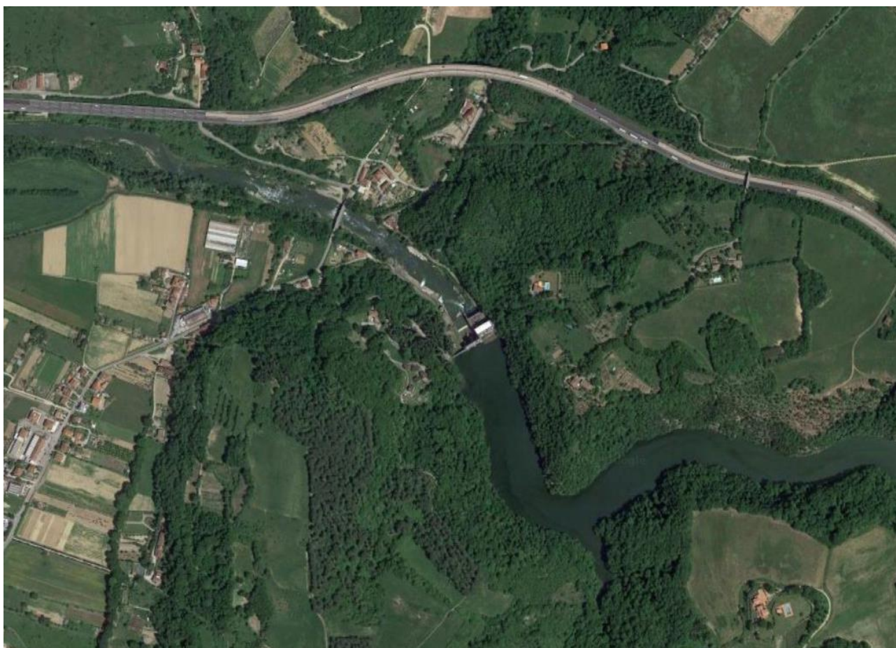
Figura 4.9:1 – Diga di Levane. Fonte Google Maps
