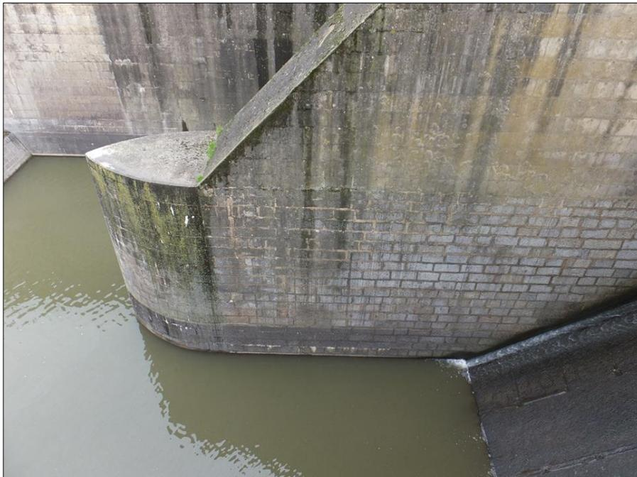
**Foto 21: vista del rivestimento in pietrame della pila centrale**
