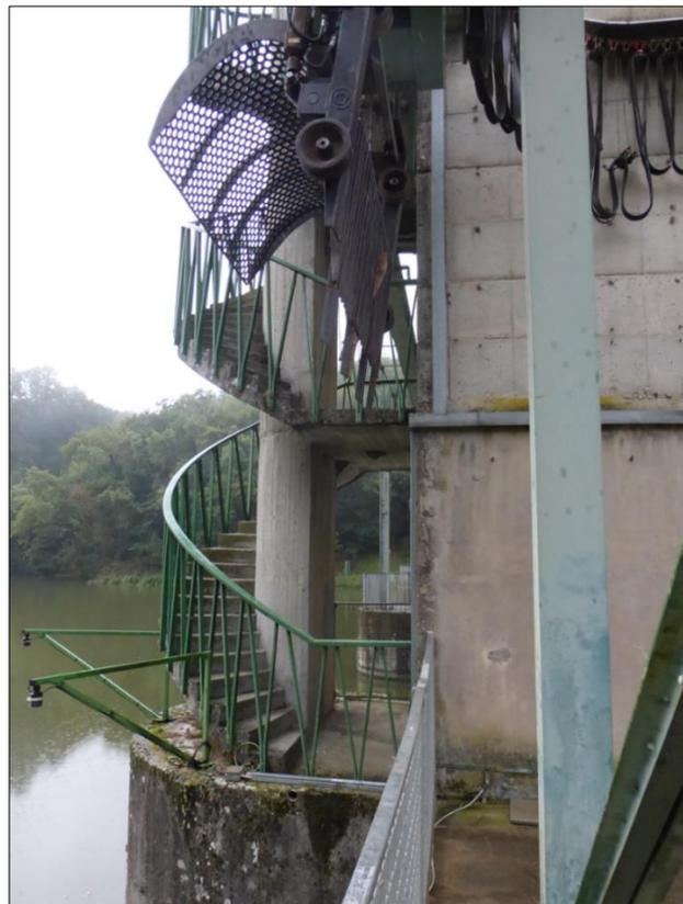
**Foto 20: vista della scala di accesso alla passerella di comando delle paratoie**
