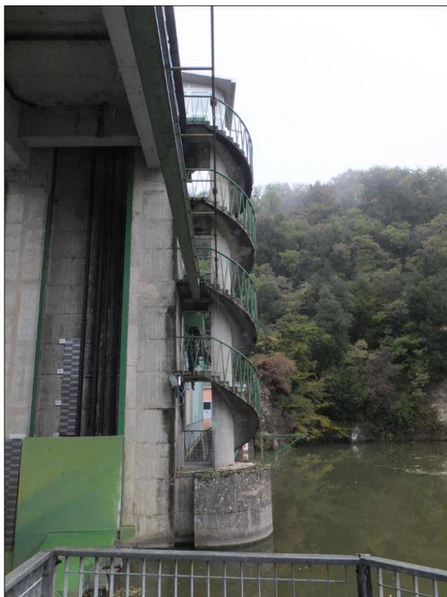
Foto 10: scala di accesso alla passerella di manovra degli scarichi di superficie
