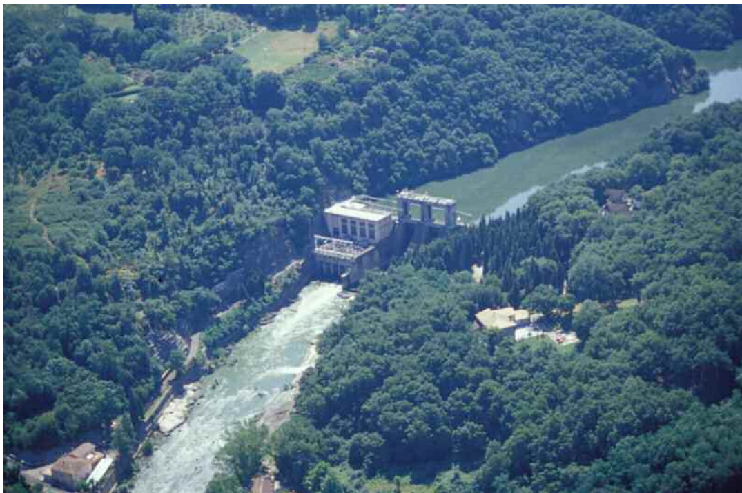
Fig. 5: Panoramica dello sbarramento dall'alto 1
