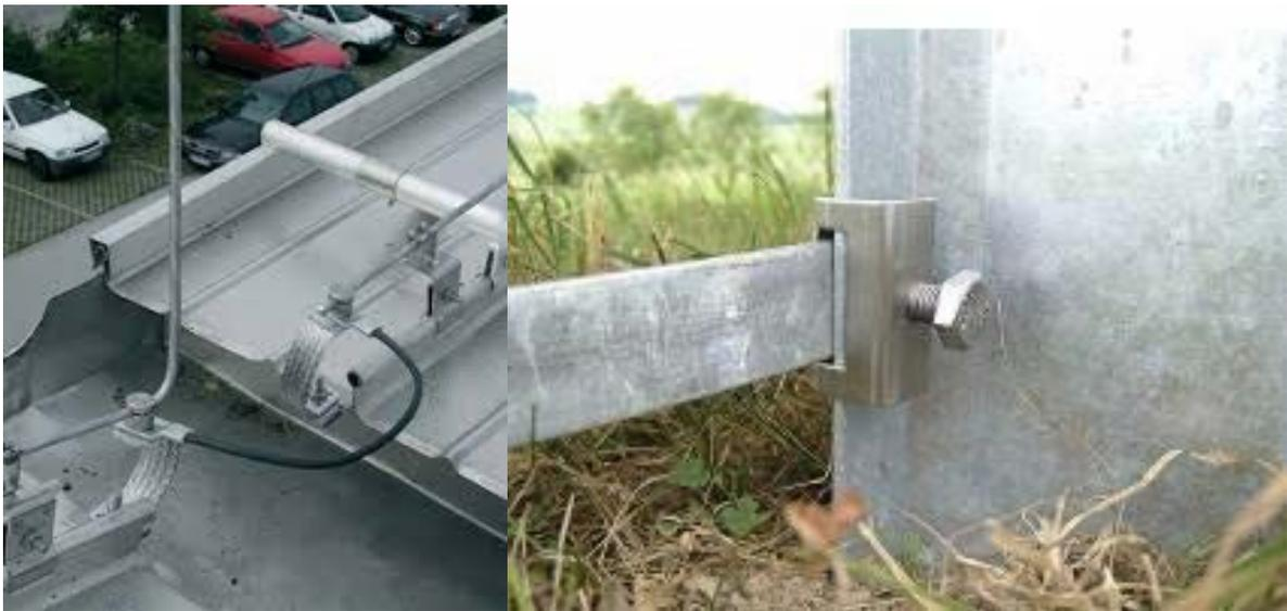
**Figura 7** – Punta di captazione con fissaggio tramite morsetto e Punta di captazione con fissaggio tramite morsetto.
