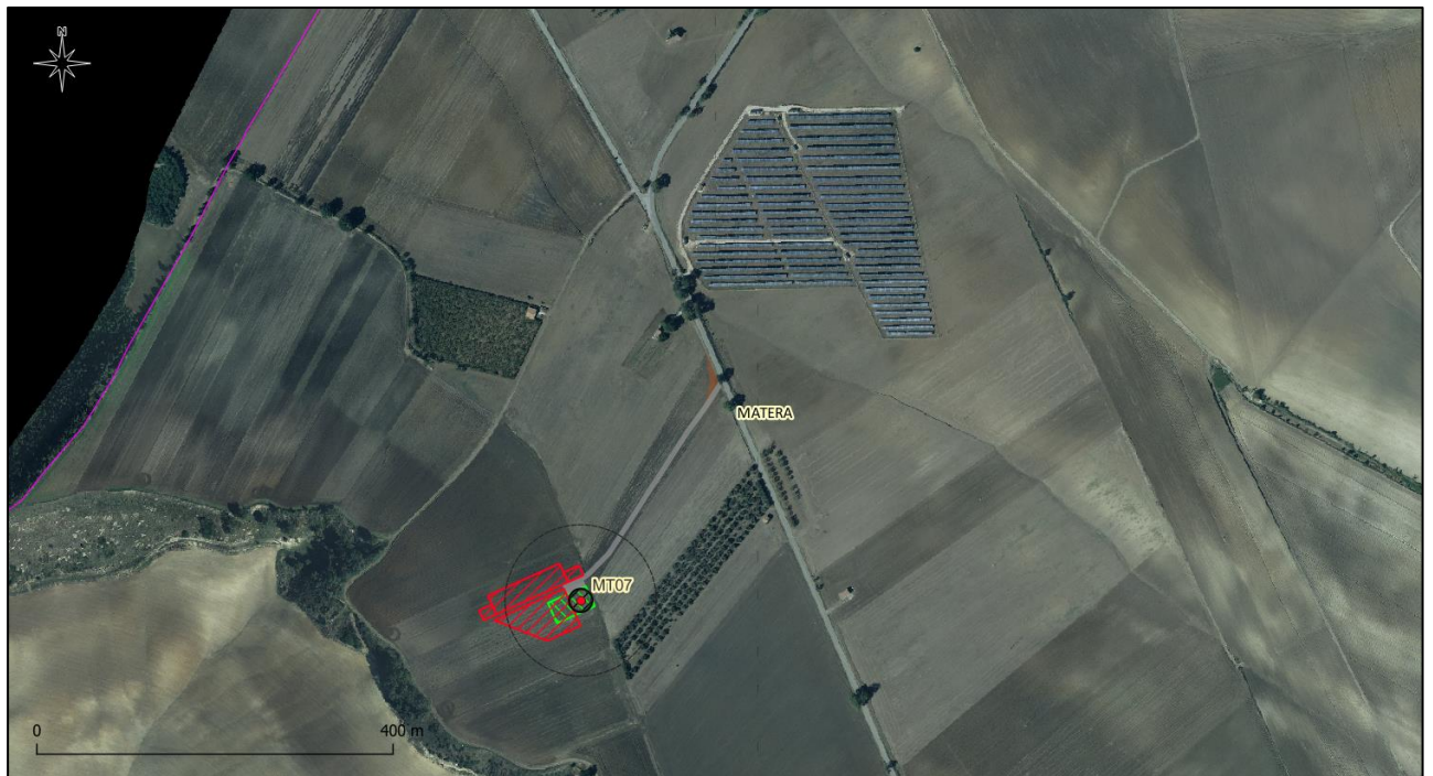
Strada di accesso alla WTG N. 7
