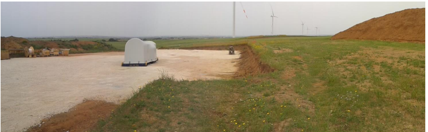
Fig. 6.3 - Piazzola di Cantiere (a sinistra) e Piazzola stoccaggio Pale (a Destra)
