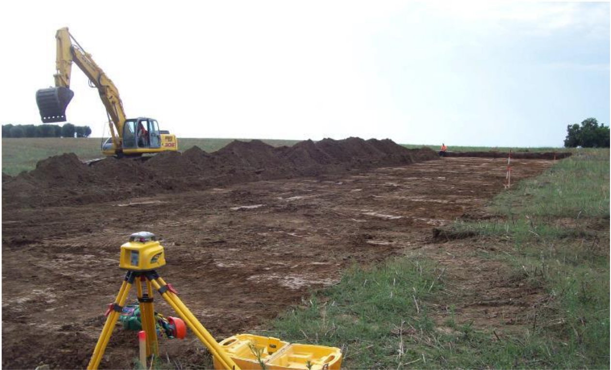
Fig. 6.2 - Scavo di sbancamento per la realizzazione di una nuova piazzola
