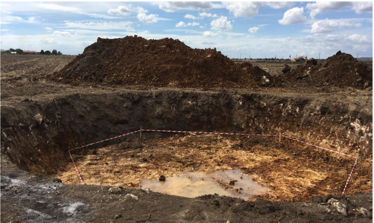
Fig. 6.5 – Scavo Fondazione Plinto Aerogeneratore
