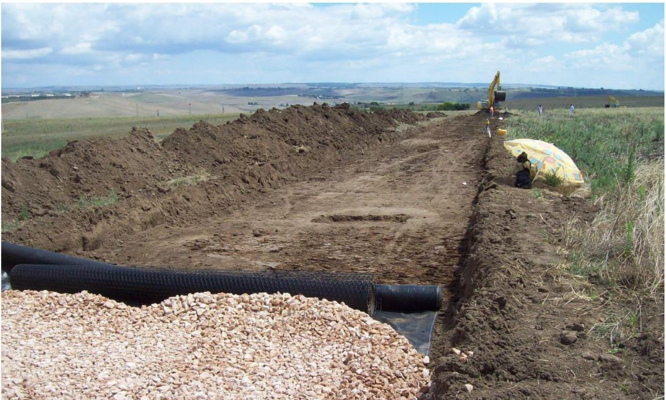
Fig. 6.1 - Viabilità di nuova realizzazione – Fase di scavo superficiale (scotico) con inizio di posa di massicciata e geogriglia
