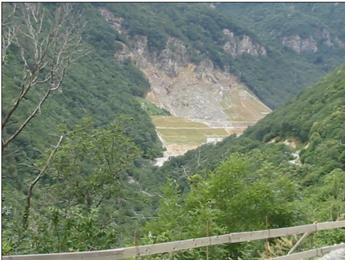
Fotografia 1: Il cantiere del bacino A.E.M. di Pont-Ventoux visto dalla strada di accesso alla Val Clarea.
