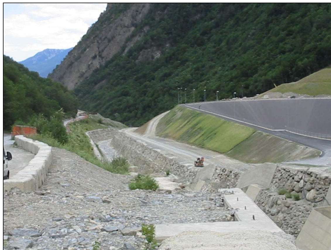
Fotografia 3: Vista verso valle del bacino A.E.M. in costruzione
