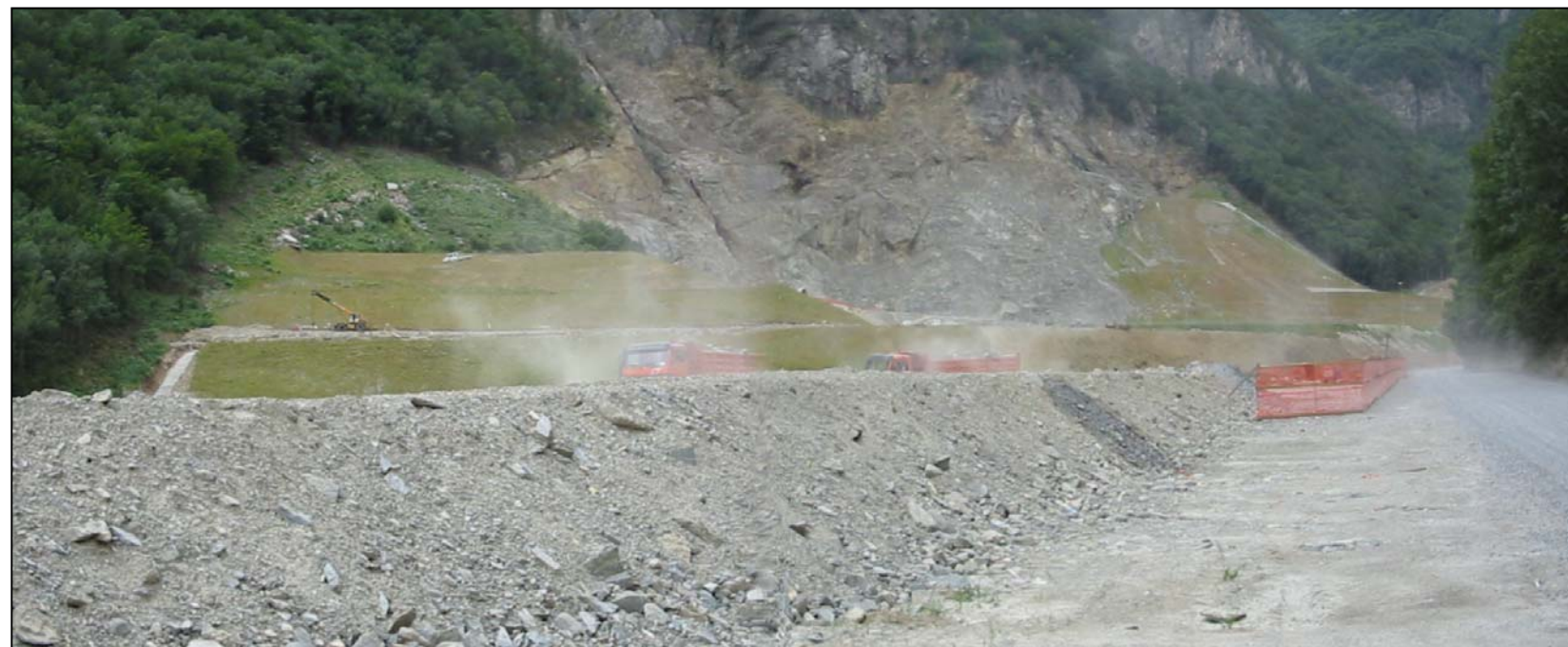
Fotografia 2: La pista di accesso al cantiere ed alla valle presso il bacino in corso di costruzione (vista verso monte)
