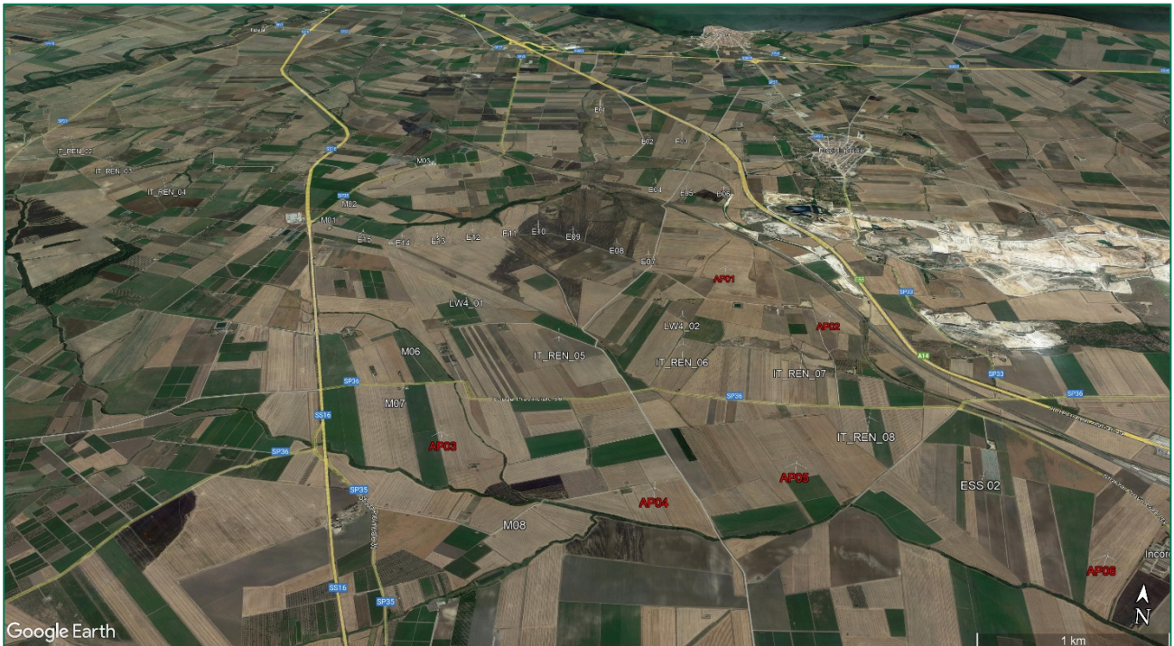
Figura 6: Layout di progetto (Incoronata) con evidenza di tutti gli impianti considerati su stralcio ortofoto Google Earth (3D)
