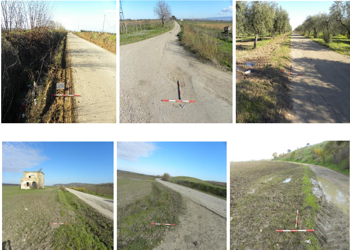
Cavidotto esterno con relativo grado di visibilità, gruppo torri AP01-06.
